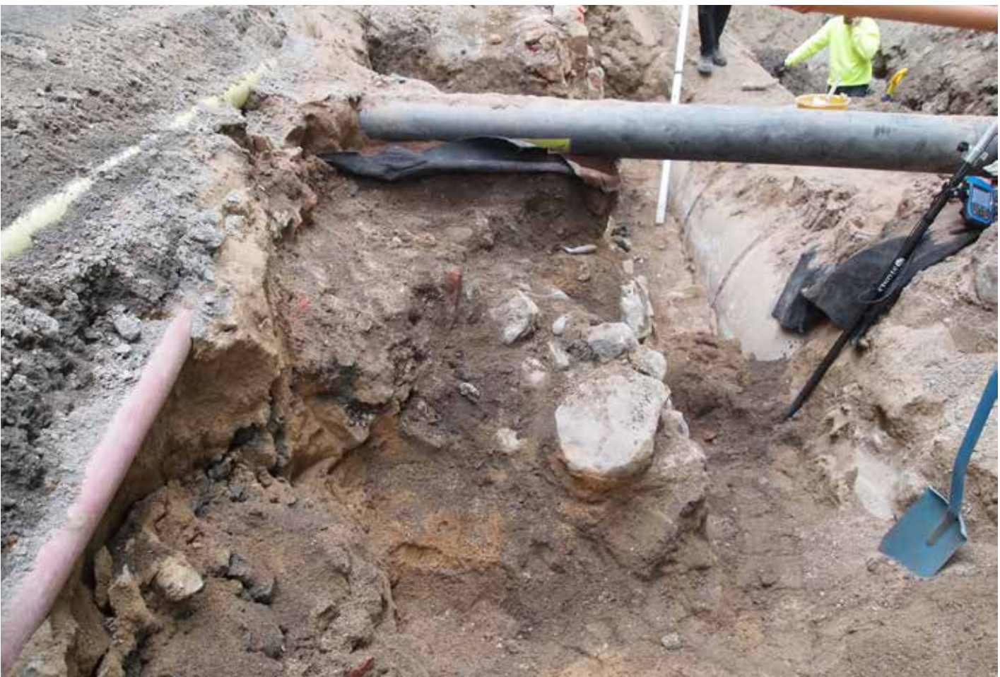
DT2016:74:7. Tiilirakenne R101 poistettu, alta täytöt M102 sekä laastin ja tiilen sekainen hiekka M106. N. JH.
