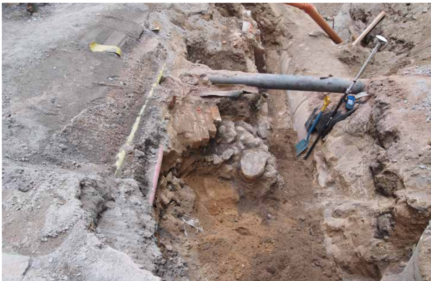
DT2016:74:6. Mustan kaukolämpöputken pohjoispuolella vino tiilirakenne R101 ja sen alta tuleva pyöreiden kivien sekainen sora M102. N. JH.
