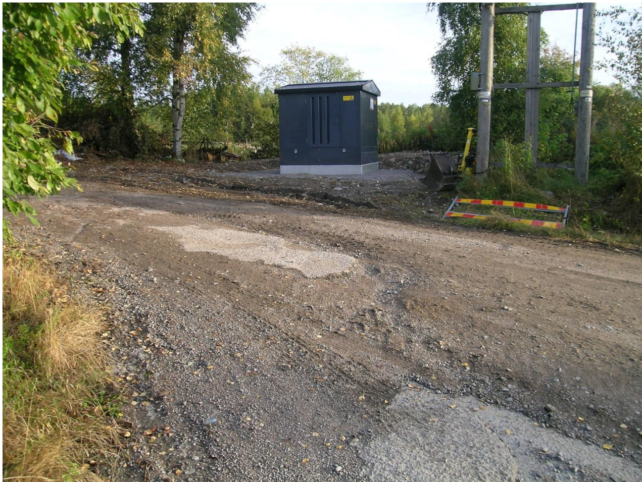
Kuva 1, valvontapaikka koilliseen nähtynä ennen kaivutyön alkua. Tiellä erottuu asfalttijäänöksiä. Sivutien toisella puolella näkyy muuntamo, jonka takana sijaitsee hevoshaka. Kuva: Sami Raninen. KYY 162: 1.
