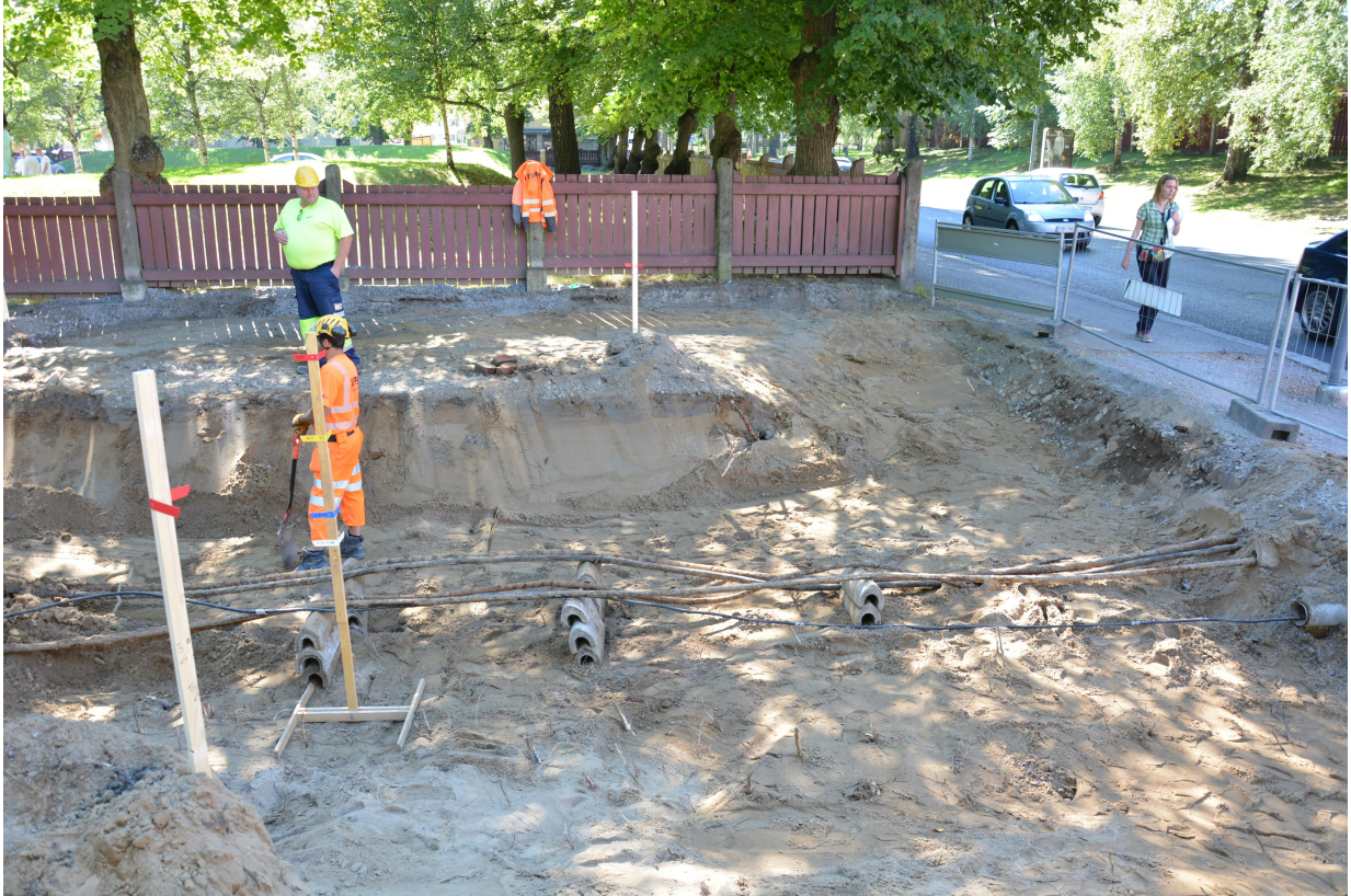
Kuva 12. Valvonta-alueen länsipäätä, jossa kaapeleita on otettu näkyviin. Kuva: Ulla Moilanen (KYY 163: 34).
