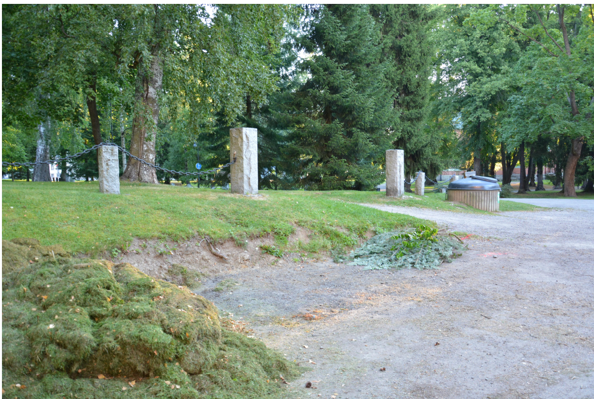
Kuva 3. Valvonta-aluetta hautausmaan kaakkoisnurkalla länsilounaasta kuvattuna. Kuvassa näkyy valli, jota on selvästi kaivettu koneellisesti. Kaivannon vieressä tien alla kulkee kaapelilinja. Kuva: Ulla Moilanen (KYY 163: 12).
