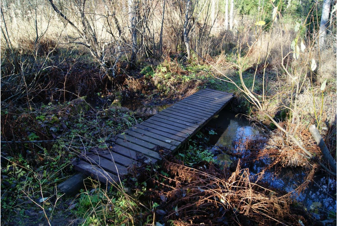
Kuva 9. Kohde 5. Vanha tie muuttuu läpipääsemättömäksi pian ojan ylittävän sillan jälkeen. Sillan vieressä ojan ympäristössä on nähtävissä jäänteitä vanhemmasta ja tukevarakenteisemmasta sillasta. Kuvattu pohjoisluoteesta. Kuva: Eva Gustavsson.
