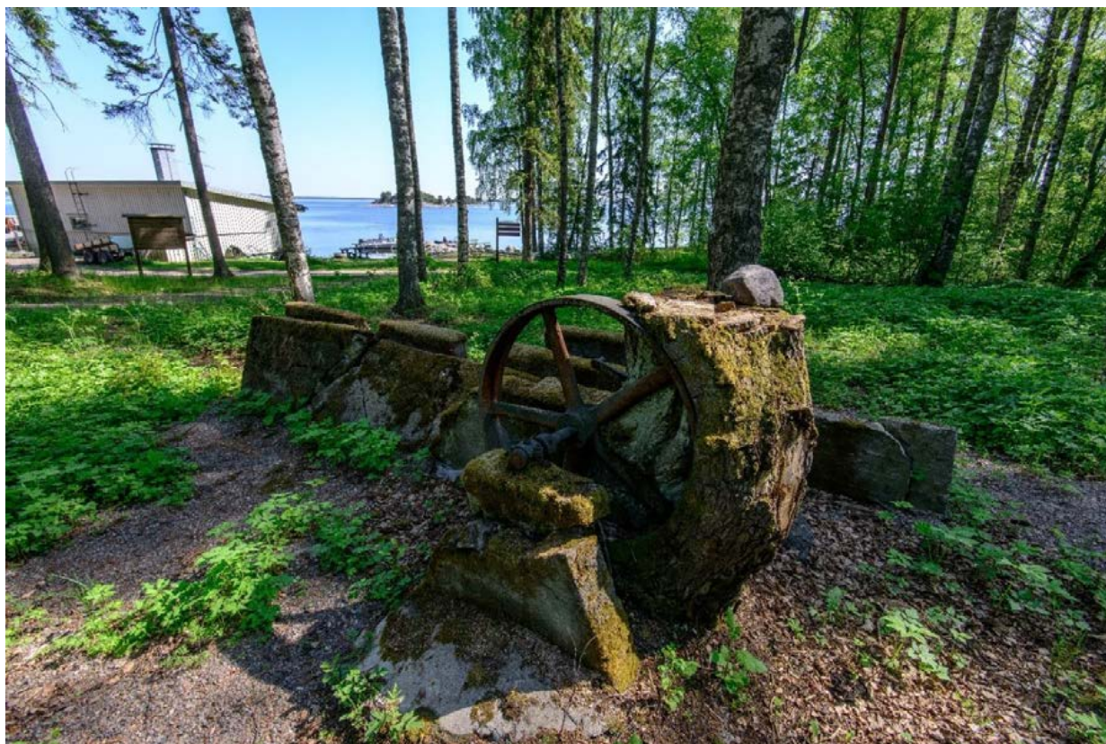
Kuva 7. Erheellisesti 1700-luvun sahan jäännökseksi oletettu rakenne lähellä saaren päälaituria. Betonirakenteisena se lienee peräisin aikaisintaan 1800-luvun lopulta. Kuva: Vesa Laulumaa/ARKE (AKDG4811:1).
