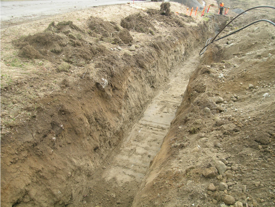
Kuva 2. Järviöntien eteläpuolista kaivantoa. Kuvattu itään. Kuvaaja: Sami Raninen. KY 154: 4.
