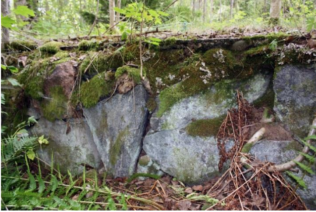
Kuva 34. Rakennusjäännöksen kivijalka, jonka päällä on betonista valettu lattiataso, kuvattu luoteesta. AKDG 4878:10
