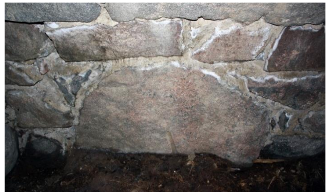
Kuva 29. Porajälki holvirakenteisen maakellarin seinän alimmassa kiverroksessa olevassa kivessä, kuvattu pohjoisesta. AKDG 4878:25
