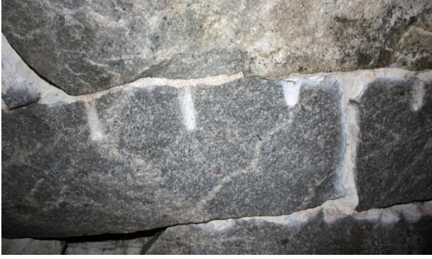
Kuva 28. Porajälkiä maakellarin holvirakenteessa olevissa kivissä, kuvattu etelästä. AKDG 4878:24
