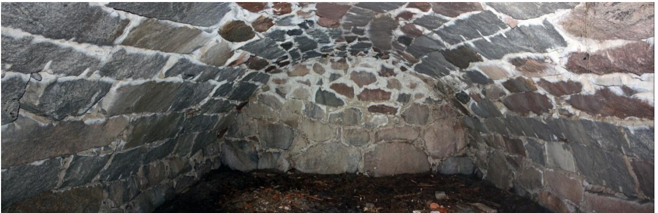
Kuva 26. Holvirakenteisen maakellarin sisätila, kuvattu lännestä. AKDG 4878:23
