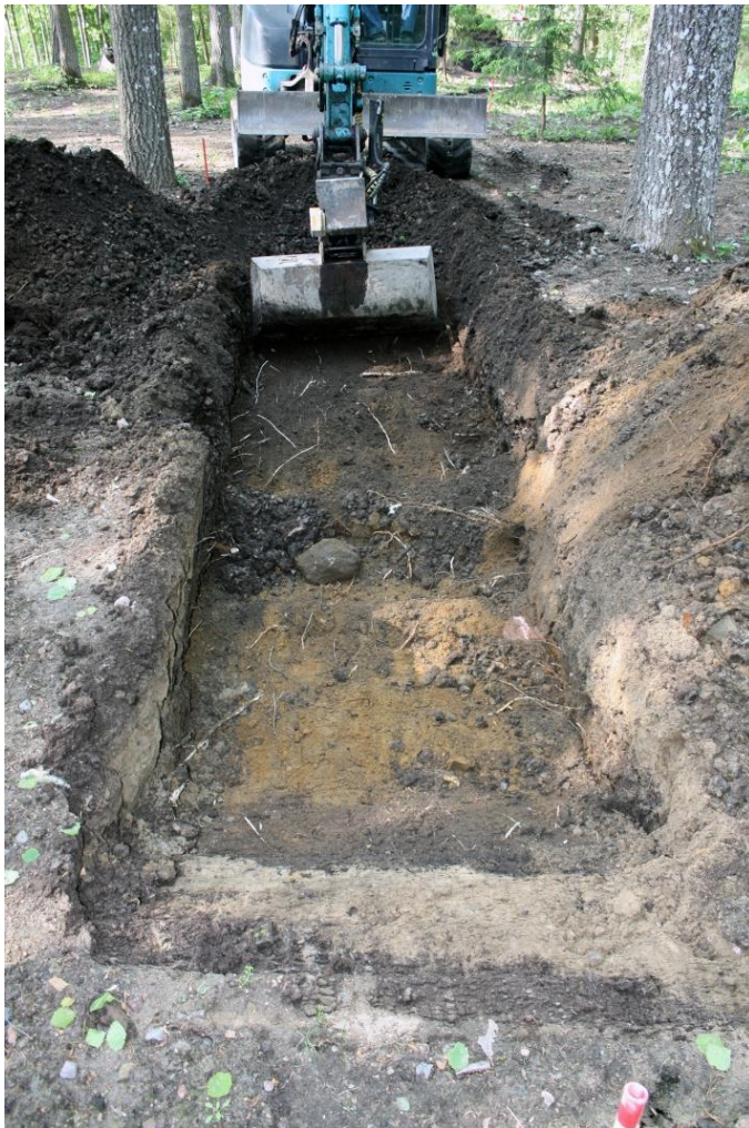
Kuva 7. Koeoja 1:n pintamaat poistetaan kaivinkoneella, kuvattu koillisesta. AKDG 4867:5
