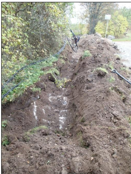
Tilustien eteläpuolella ollut valvotun linjan itäisin osa, jossa kallio oli aivan lähellä maanpintaa. Tilustie oikealla. Kaakosta.
