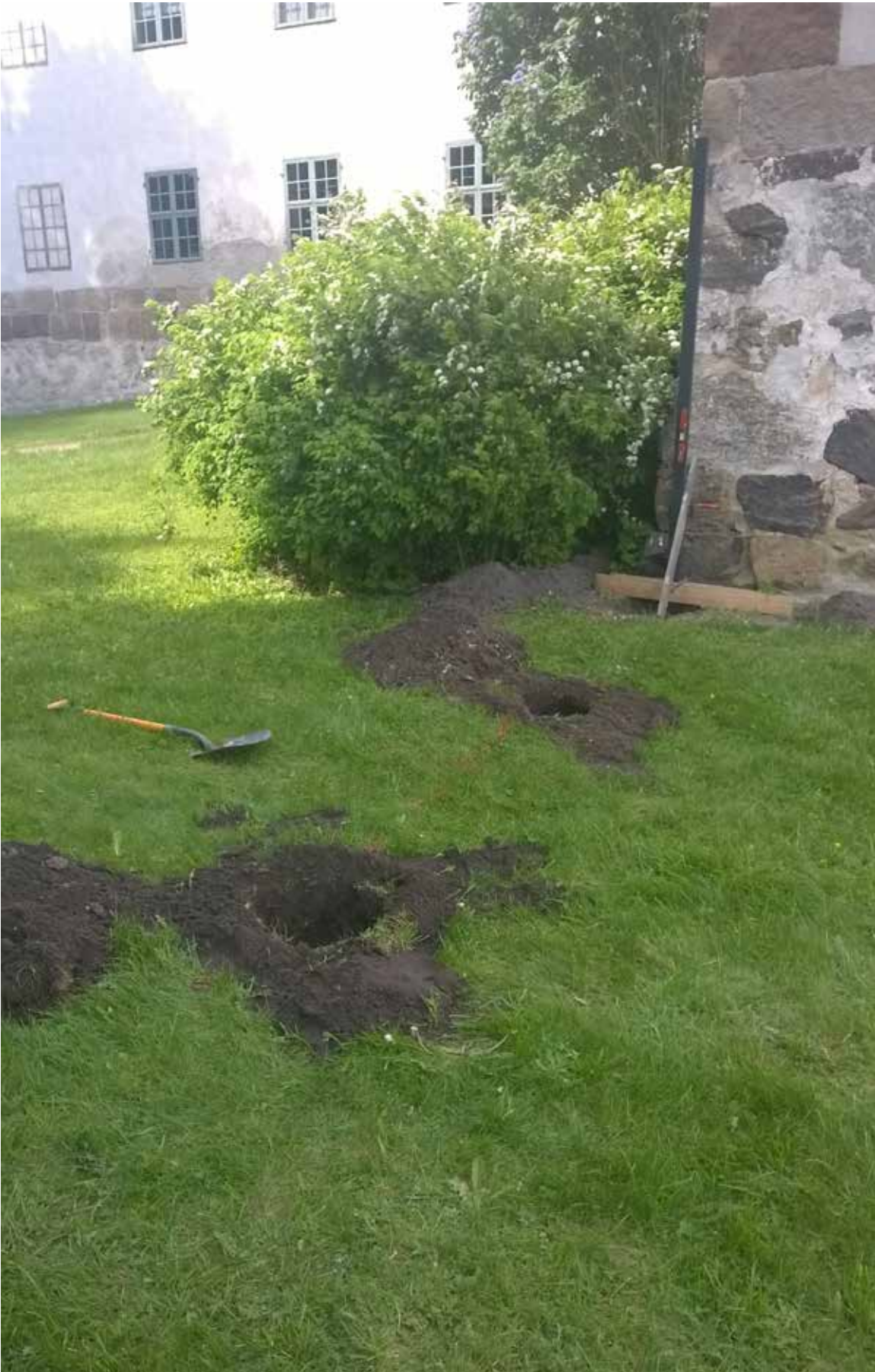
Kuva MuTu116010:1. Itäisen siipirakennuksen eteläkulman edustan kolme paalukuoppaa. SE. KU. Toukokuu 2016.
