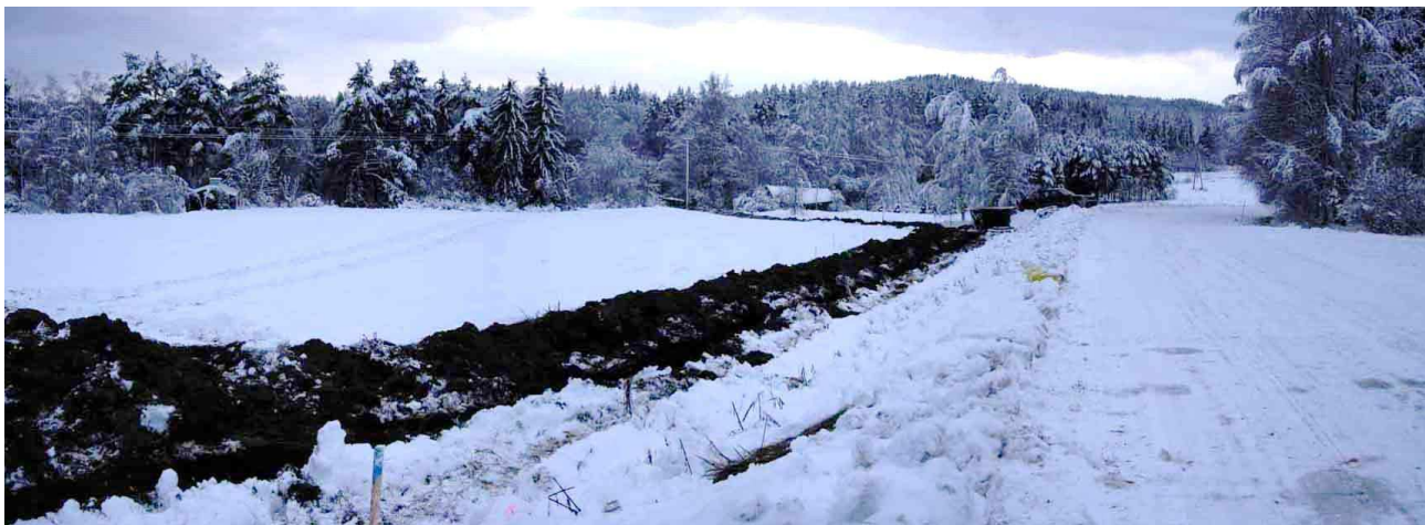
Kuva 3. Valmis kaapelikaivanto Siitamantien (kuvassa oikealla) eteläpuolella. Kuvattu koillisesta. (Kuva: Kangasala Haviseva 2015:1)
