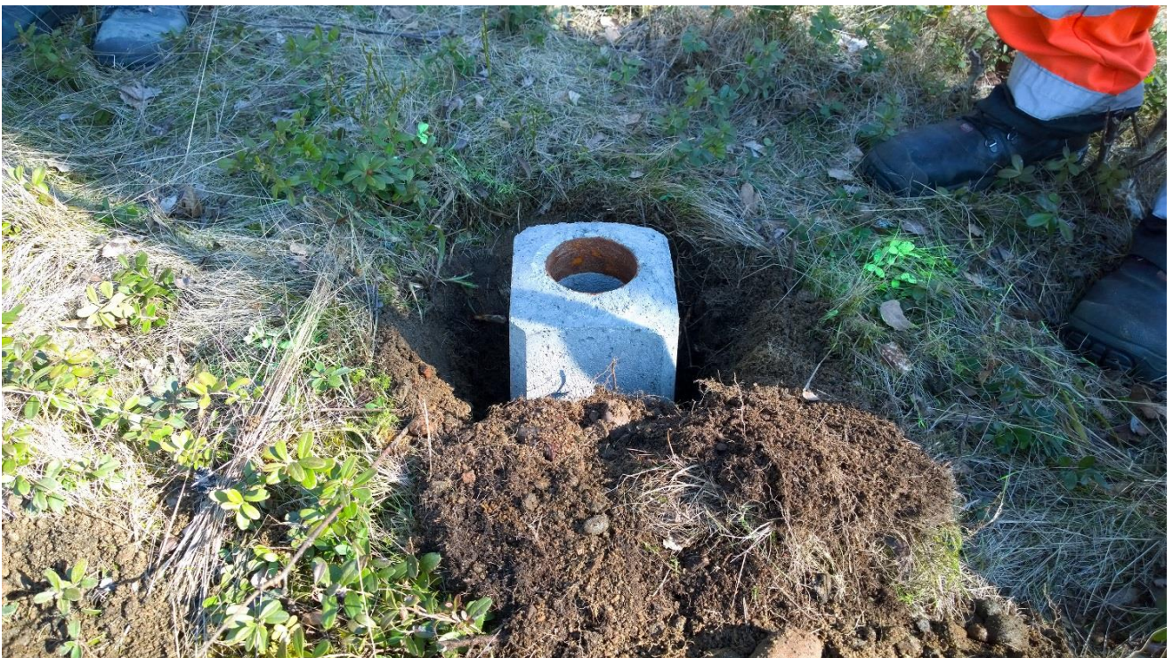
Kuva 6. Putken betoninen jalusta asennuskuopassaan. Kuva: Satu Koivisto/ARKE (AKDG 5037:6).
