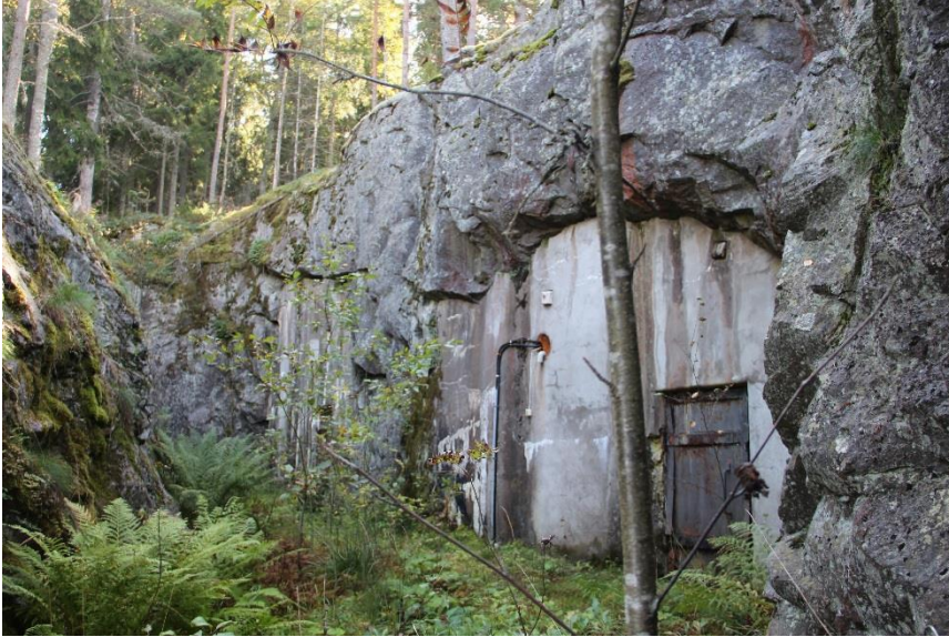
AKDG 4877:85. Itä-Villinki, varuskunnan suojatunnelit. Kuvaaja: J. Lagerstedt.
