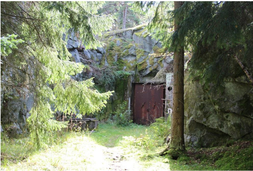
AKDG 4877:71. Itä-Villinki, suoja- ja voima-asema. Kuvaaja: J. Lagerstedt.
