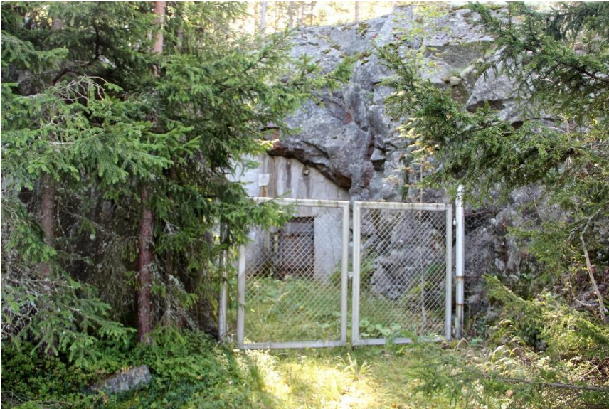
AKDG 4877:86. Itä-Villinki, varuskunnan suojatunnelit. Kuvaaja: J. Lagerstedt.
