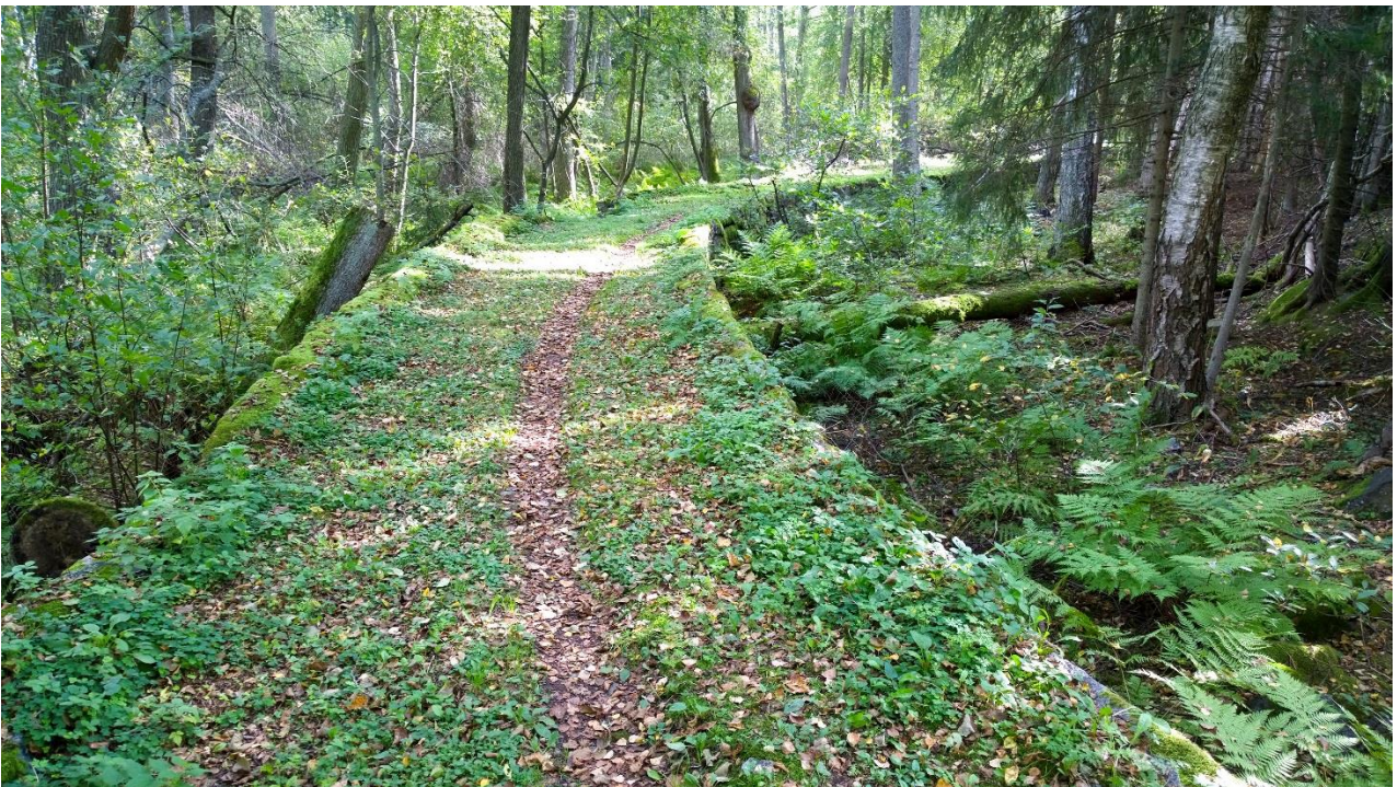
Kuva 8. Valonheitinaseman rata on huolellisesti pengerrytetty. Kuva: Satu Koivisto/ARKE (AKDG 4877:70).
