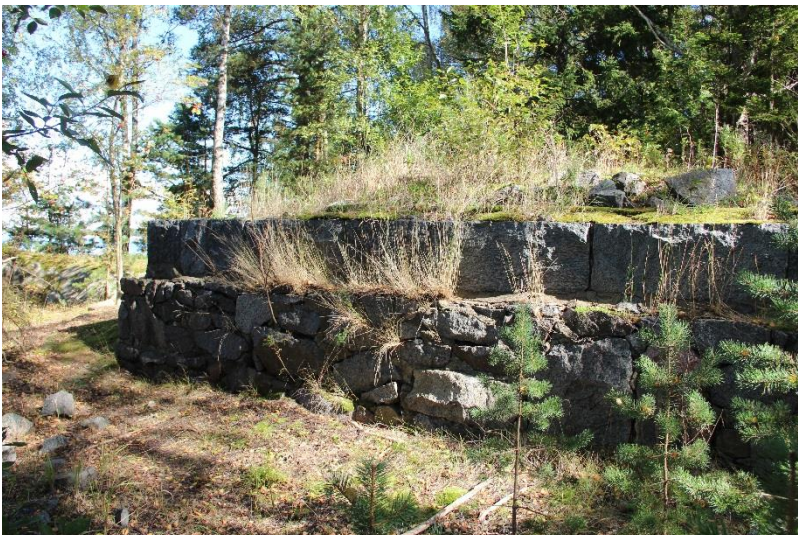
AKDG 4877:160. Itä-Villinki, rakennuksen perusta. Kuvaaja: J. Lagerstedt.
