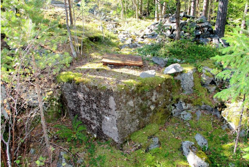
AKDG 4877:154. Itä-Villinki, kaapelikaivo. Kuvaaja: J. Lagerstedt.
