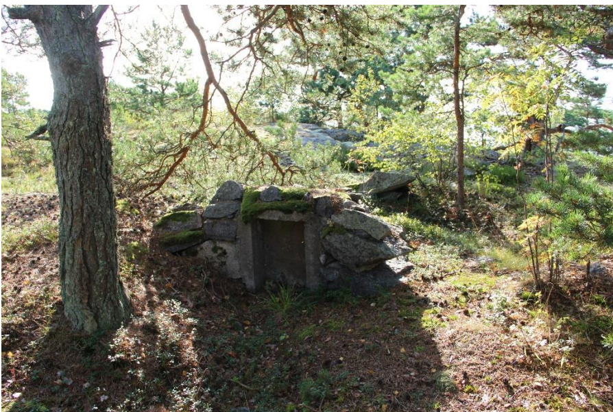
AKDG 4877:198. Itä-Villinki, kaapelikaappi. Kuvaaja: J. Lagerstedt.
