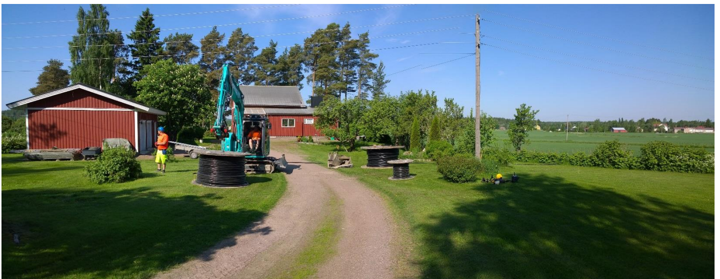
Kuva 1. Kaapeliojan kaivutyön valmistelua Valaskalliontien varressa olevalla omakotitalotontilla, Myllymäen muinaisjäännöksen luoteispuolella. Kuvattu länteen. Kuva: Satu Koivisto/ARKE (AKDG 5109:1).
