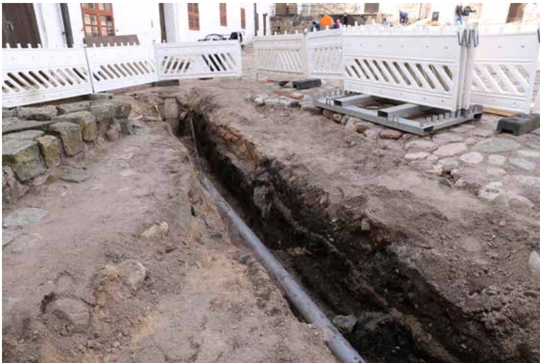
MuTu116009Dg_1. Eteläinen kaivanto (1A), NE-SW-putkikaivanto. Luoteisprofiili yleiskuva. 9.8.2016, SE-NW, M. Helamaa.
