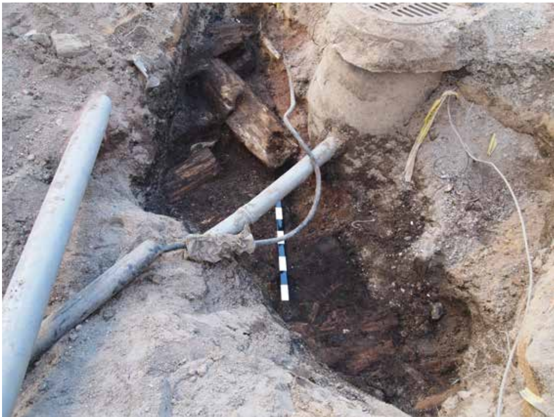
MuTu116009Dg_33. Pohjoinen kaivanto (2D), salaojakaivon 3 aiottu paikka. Hirsirakenteet R222_1, R222_2 ja R224_1 kaivon itäpuolella ja huonokuntoiset R224_2 ja R224_3 kaivon pohjoispuolella. 14.9.2016, N-S, M. Helmaa.
