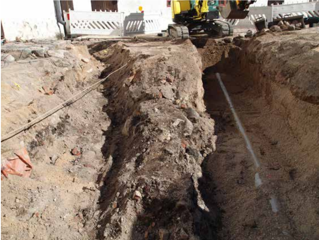
MuTu116009Dg_16. Pohjoinen kaivanto (2A). Kaivamattoman maan palkki (2A) vanhan sadevesiputken ja uuden salaojaputken kaivantojen välissä. 7.9.2016, W-E, M. Helamaa
