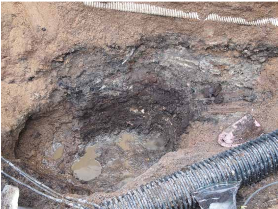
MuTu116009Dg_13. Eteläinen kaivanto (1B), salaojakaivo 1 kaivaus. Salaojakaivon kuoppa kaivettuna. Pohjalla M127 savi, paksu tumma kerros on M126, päällä M122. 30.8.2016, W-E, M. Helamaa
