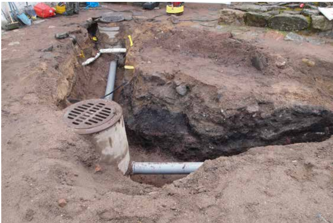
MuTu116009Dg_5. Eteläinen kaivanto (1). Yleiskuva, eteläinen putkikaivanto, etelähaara / kaakkoisprofiili ja kulma. 12.8.2016, NW-SE, M. Helamaa.
