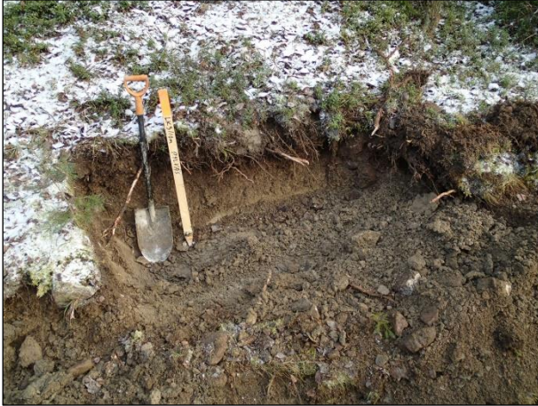
Kohtaan N 6698080 E 288926 uutta sähkötolppaa varten kaivettu ala. Etelästä.
