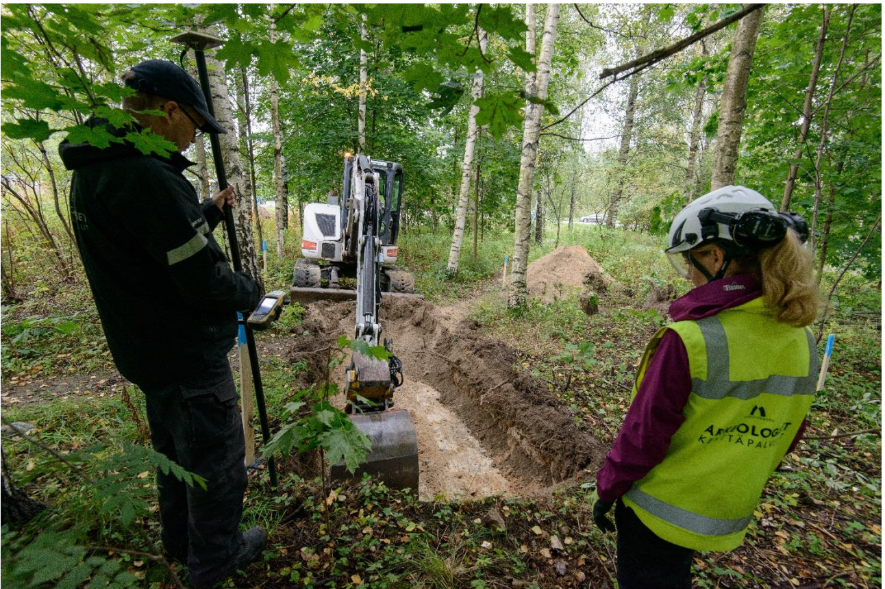
Kuva 4. Petro Pesonen ja Satu Koivisto valvovat alueen 2 kaivamista. Kuvattu pohjoiseen. Kuva: Vesa Laulumaa/ARKE (AKDG 5117:11).
