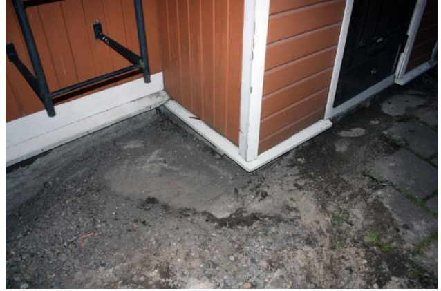
Kuva 9. Hakunin tontin kadunpuoleisen asuinrakennuksen kalliolle tehty perustus, kuvattu koillisesta. AKDG 5118:6
