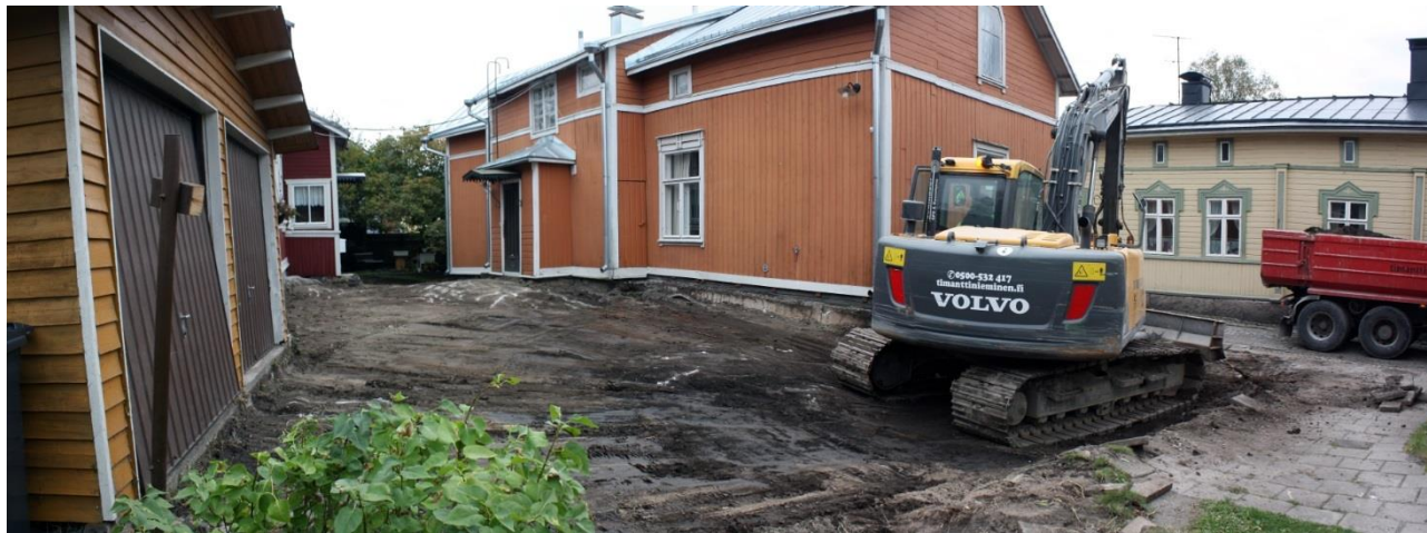
Kuva 14. Pintamaa poistettuna Hakunin tontin pihalueelta, kuvattu luoteesta. AKDG 5118:12
