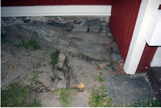
Kuva 8. Hakunin tontin pihanpuoleisen asuinrakennuksen kalliolle tehty perustus, kuvattu etelästä. AKDG 5118:5
