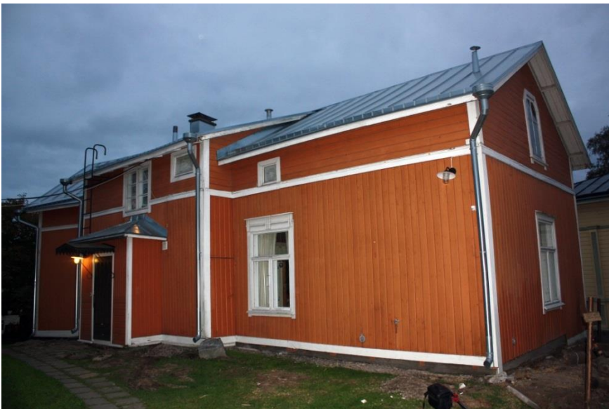
Kuva 4. Hakunin tontin kadunpuoleinen asuinrakennus, kuvattu luoteesta. AKDG 5118:4
