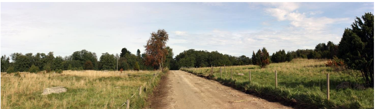
Kuva 5. Valvottavan tieosuuden itäosa, kuvattu lounaasta. AKDG 4909:5
