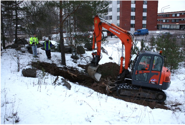
AKDG5145:4 Koeojan pohjois-eteläsuuntaista osaa kaivetaan. Länneestä. Kuva Katja Vuoristo.
