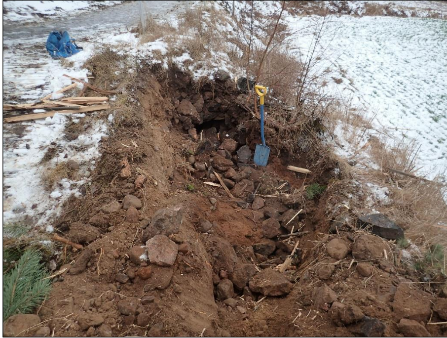
Sähköpylväs B:n kohtaa – kohta on pääosin myllättyä täytemaata. Etelään.
