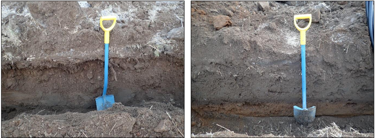
Vasen: kaapeliojan keskiosaa: peltokerroksen alla on sorakerros. Oikea: kaapeliojan pohjoisosaa, missä peltokerros on paksuin.
