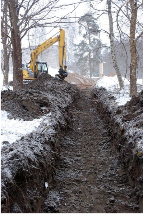
Kuva 2. Kaapelioja kaivettiin linnan länsipuolelle rakennettavan lipunmyynti- ja käymälärakennuksen ja sen länsipuolella jokirannassa sijaitsevan lähimmän sähkötolpan väliin. Kuvaussuunta W-E. Kuva: Tarja Knuutinen
