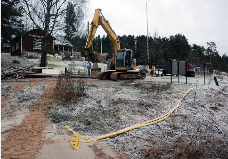
Kuva 2. Pumppukaivo sijoittuu Metsähallituksen uudisrakennuksen koilliskulmalle, vastapäätä Slottsknektens Stuga-ravintolaa. Kaivoa varten tehdyn kaivannon paikka kuvan oikeassa laidassa näkyvistä opastauluista kuvan vasempaan reunaan. Kuvaussuunta S-N. Kuva: Tarja Knuutinen
