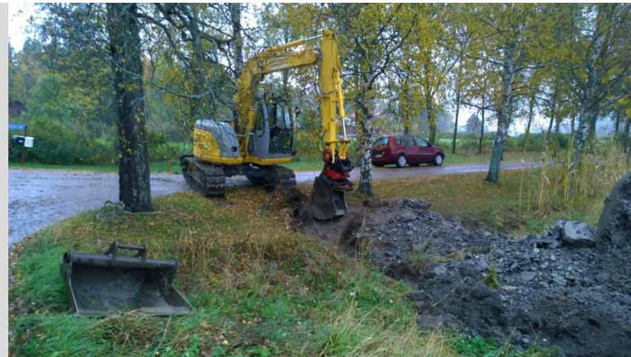
AKDG 4875:2. Louhisaari. Kaivu Louhisaarentien alkamassa, kaakosta. Kuvaaja: Petro Pesonen.
