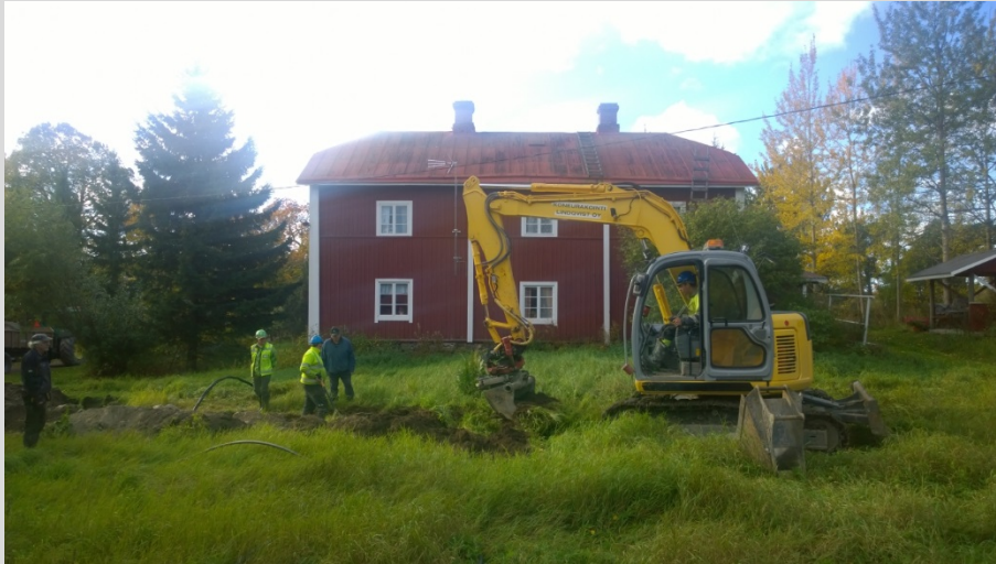
AKDG 4875:11. Louhisaari. Kaivu jatkuu pihamaalla, pohjoisesta. Kuvaaja: Petro Pesonen.
