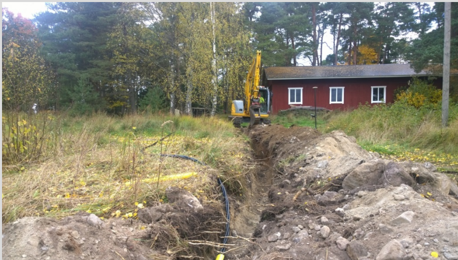
AKDG 4875:14. Louhisaari. Kaivanto kohti mäkeä, idästä. Kuvaaja: Petro Pe- sonen.
