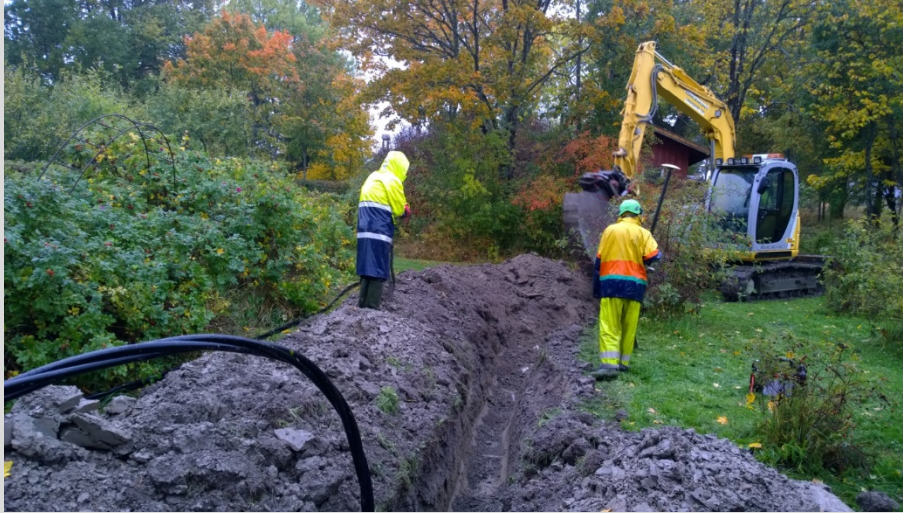
AKDG 4875:5. Louhisaari. Kaivu etenee puutarhassa, idästä. Kuvaaja: Petro Pesonen.
