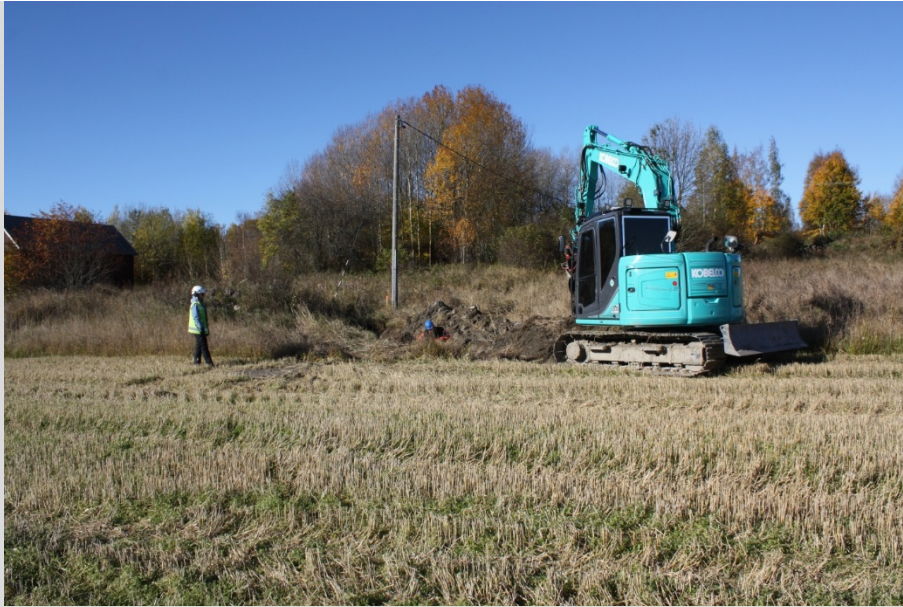
AKDG 4876:12. Saaren kartano. Työkuva. Vaihtoehdoista kaivantoa aloitetaan linjan eteläpäässä pellon reunassa. Etelästä. Kuvaaja: Johanna Seppä.
