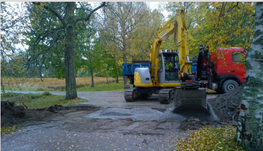
AKDG 4875:4. Louhisaari. Louhisaarentien kaivantoa laitetaan kiinni, pohjoisesta. Kuvaaja: Petro Pesonen.
