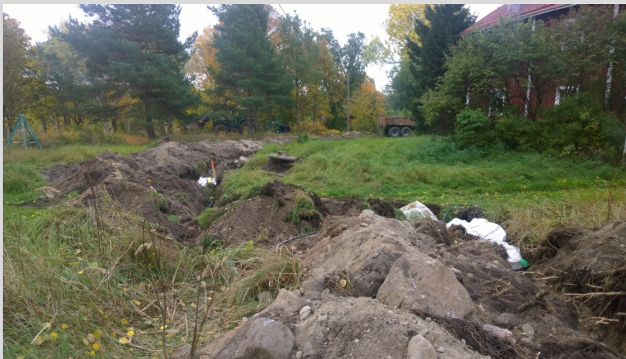
AKDG 4875:13. Louhisaari. Pihamaan kaivantoa, län- nestä. Kuvaaja: Petro Pe- sonen.
