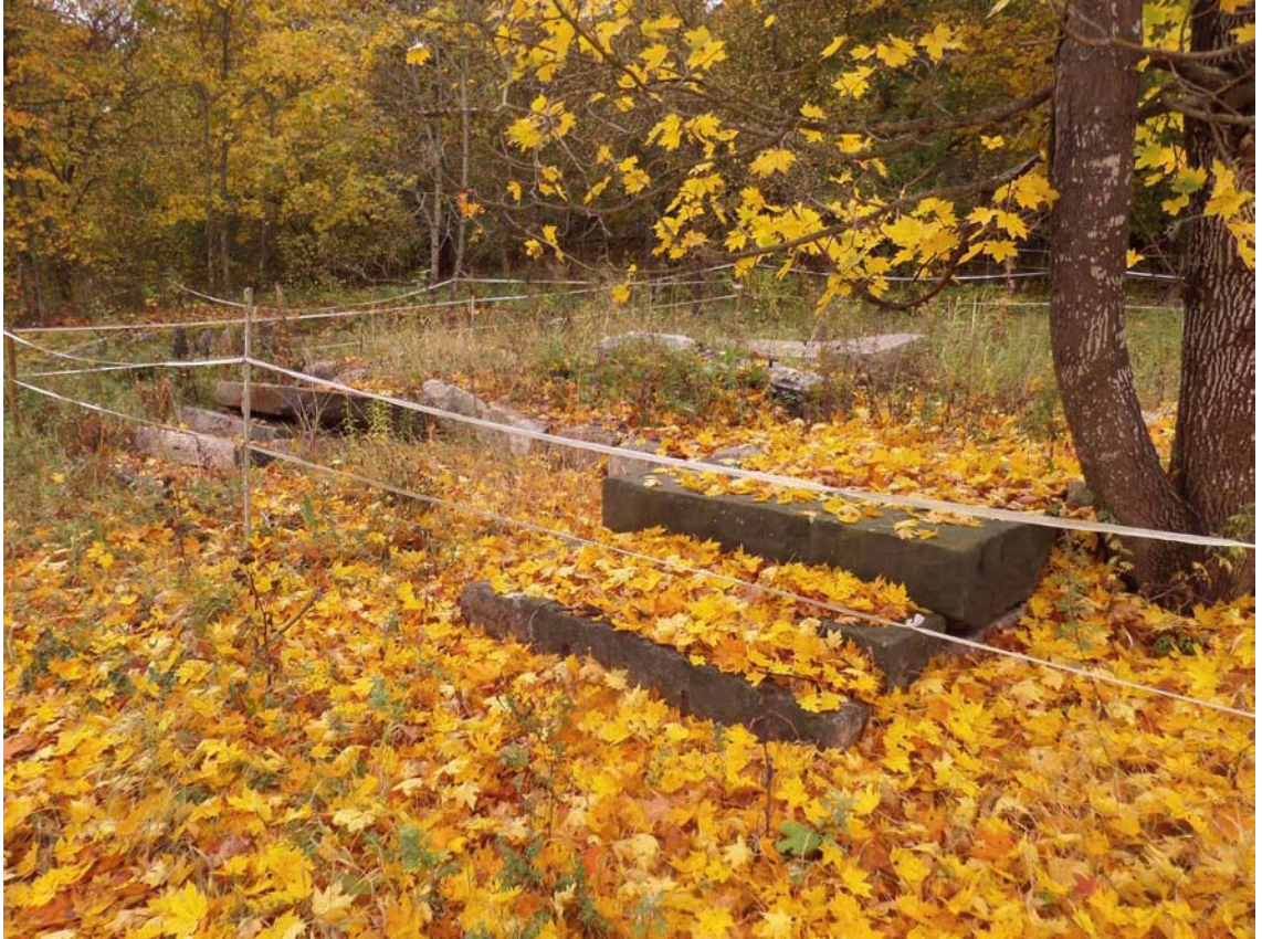
SAM_4360: 29.9.2016. Rakennuksen 10 eli kivimakasiinin perustuksen jäänteitä. Kuvaussuunta NE.
