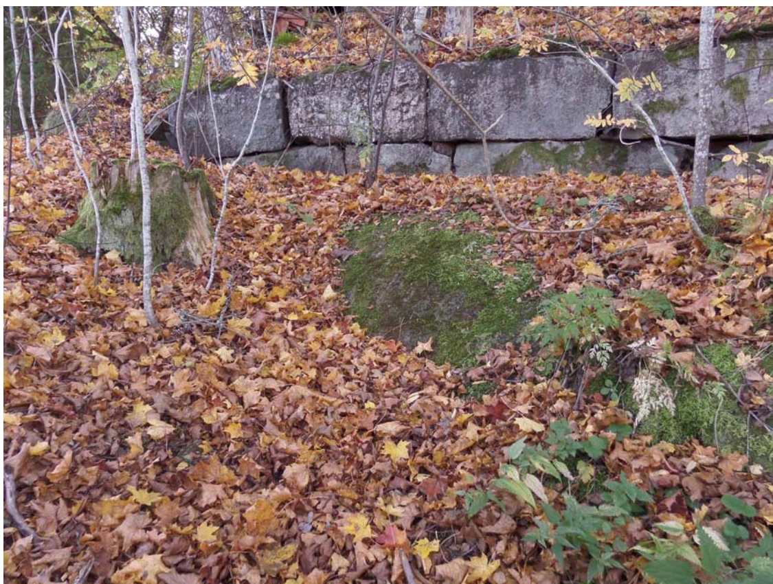
SAM_4462: 5.10.2016 Kasarminmäki. Hakkauksen sijainti ja sen yläpuolella olevan pumppaamon tukimuuria. Kuvaussuunta SE.
