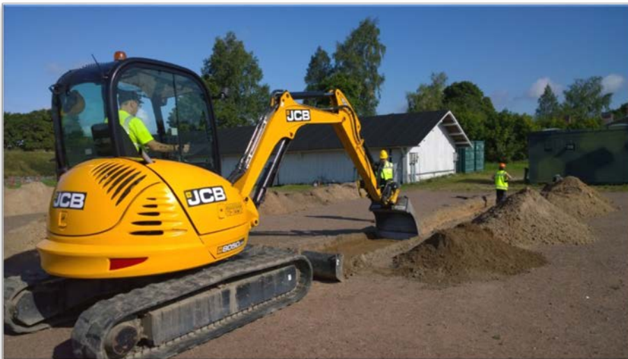
AKDG 4873:23. Koejaa 4 kaivetaan, etelästä. Ku- vaaja: Petro Pesonen.
