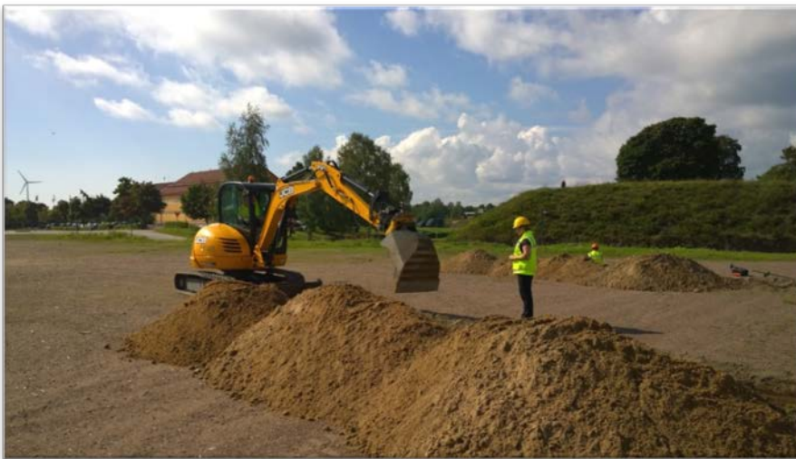
AKDG 4873:5. Koeojia kaivetaan. Kuvaaja: Petro Pesonen.
