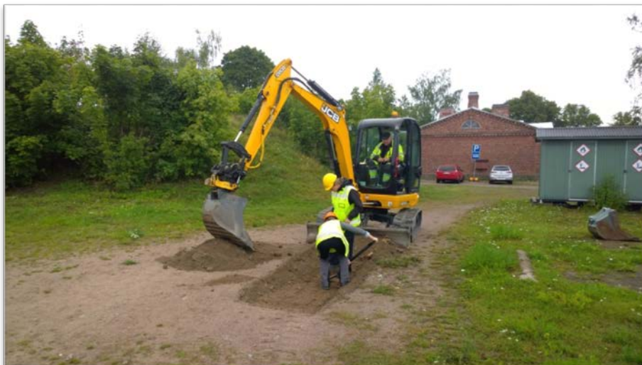
AKDG 4873:55. Koeojaa 11 kaivetaan, etelästä. Ku- vaaja: Petro Pesonen.
