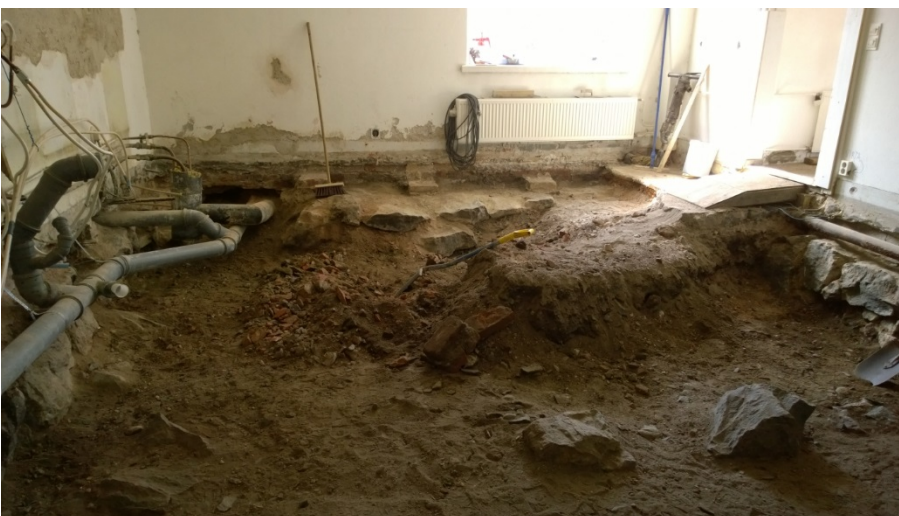
AKDG 5108:30. Työtilanne 25.4 iltapäivällä klo 14 aikaan, pohjoisesta. Kuvaaja: Petro Pesonen.
