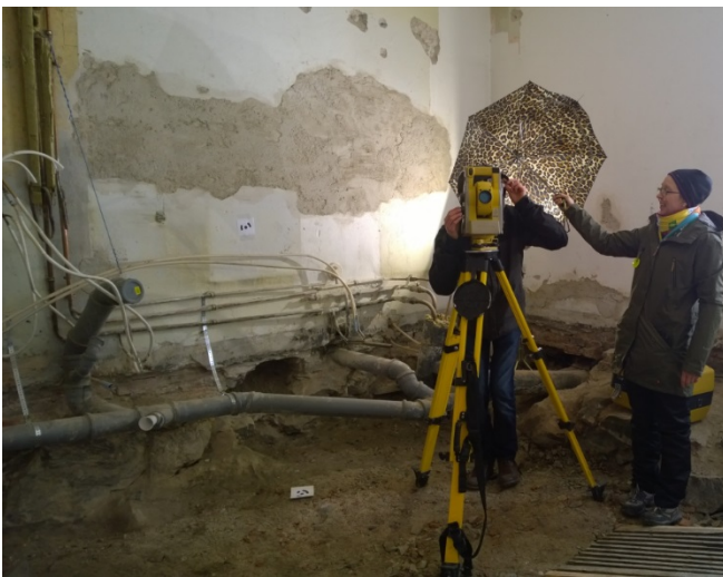
AKDG 5108:33. 3D-kuvauksen kiintopisteitä mitataan. Sateenvarjo varjostaa takymetriä valonheittimen liialta kirkkaudelta. Kuvaaja: Petro Pesonen.
