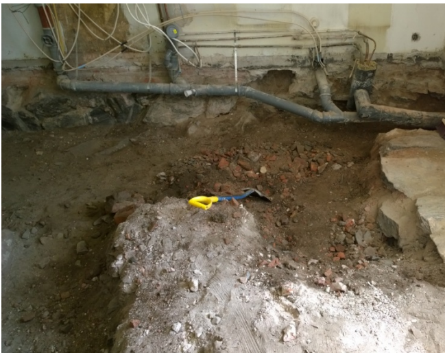
AKDG 5108:31. Työtilanne 25.4 iltapäivällä klo 14 aikaan, lännestä. Putket on tuettu ja johdot kiinnitetty seinälle. Kuvaaja: Petro Pesonen.
