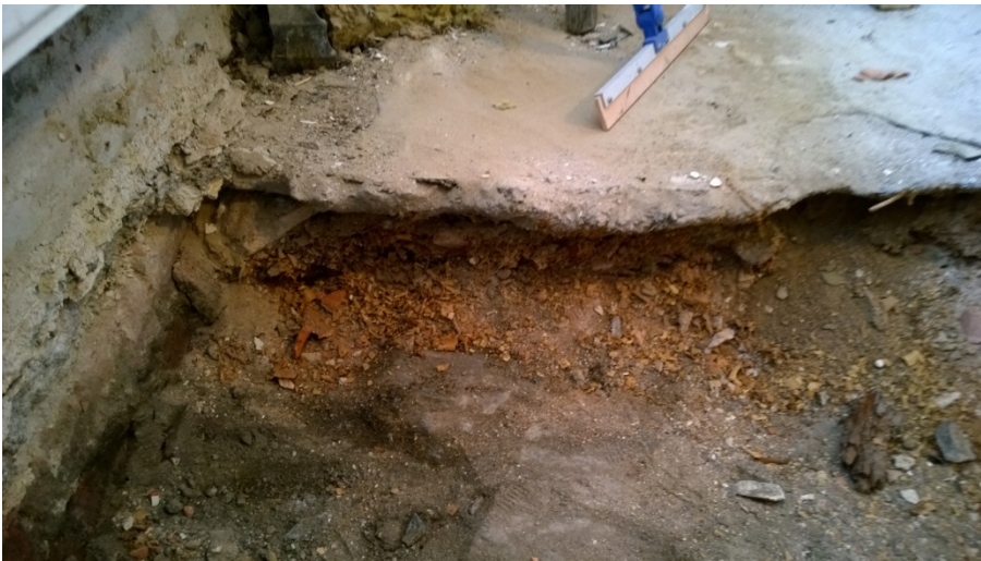
AKDG 5108:2. Purua betoni-laatan alla, idästä. Kuvaaja: Petro Pesonen.
