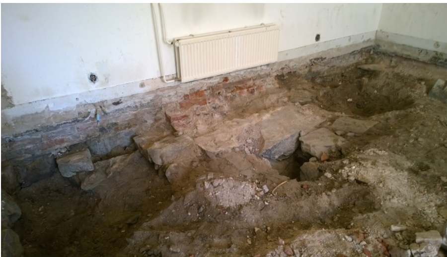
AKDG 5108:11. Pohjoisseinän kaivaustilanne 19.4. klo 13, lounaasta. Kuvaaja: Petro Pesonen.
