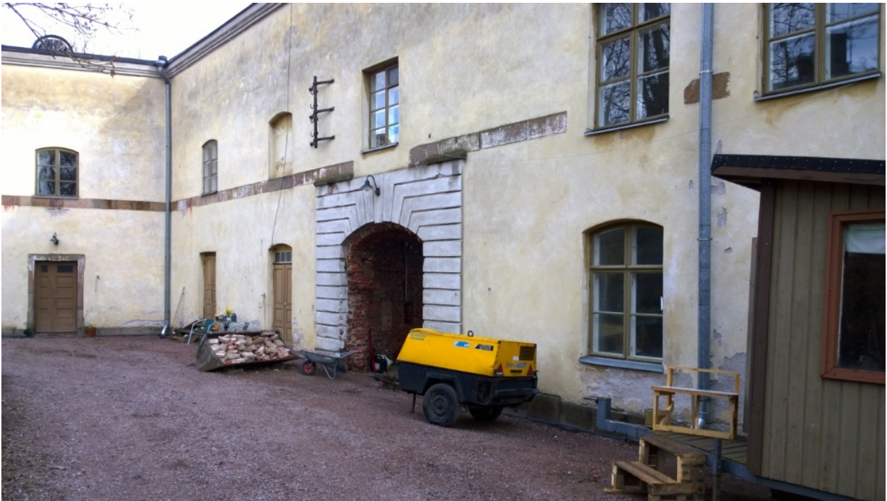
AKDG 5108:6. Yleiskuva tutkittavasta asunnosta ulkoa, kaakosta. Kuvaaja: Petro Pesonen.
