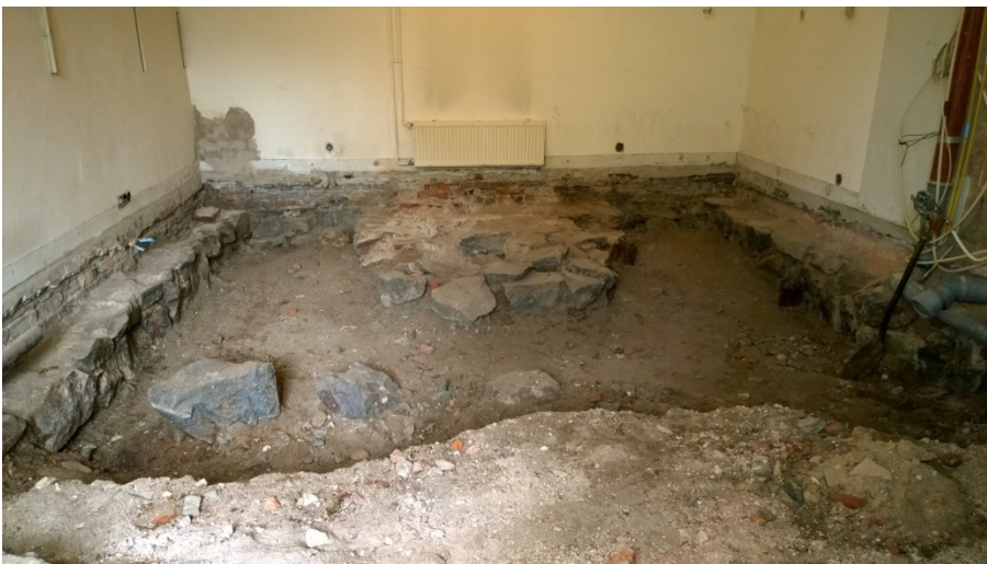
AKDG 5108:20. Pohjoisosan kaivutilanne 22.4, etelästä. Kuvaaja: Petro Pesonen.
