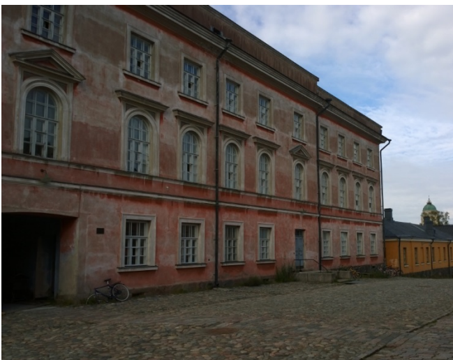
AKDG 4903:17. Rakennuksen c83 etupiha, kaakosta. Kuvaaja: Petro Pesonen.
