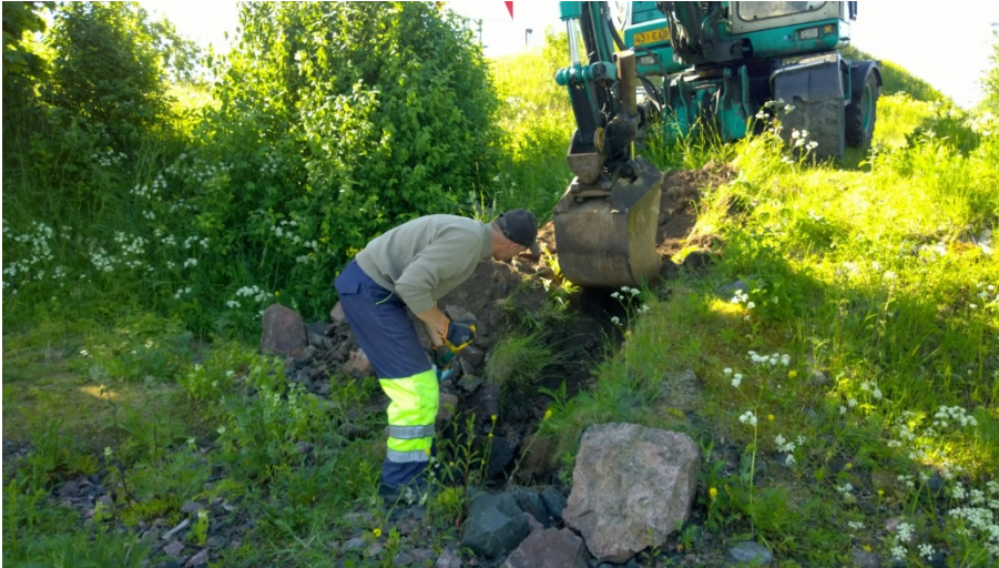
AKDG 5119:4. Merikaapelia aletaan kaivaa esiin, luoteesta. Kuvaaja: Petro Pesonen.
