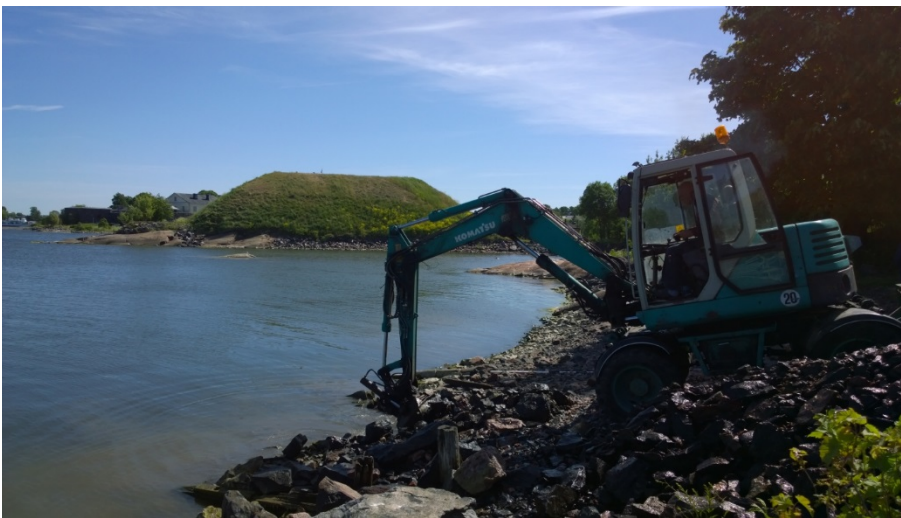
AKDG 5119:12. Kaapeliojan kaivua veden alla, lännestä. Kuvaaja: Petro Pesonen.
