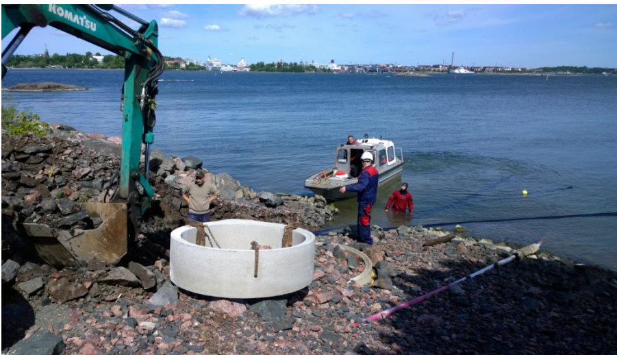
AKDG 5119:18. Merikaapelin asennusta veteen, idästä. Kuvaaja: Petro Pesonen.
