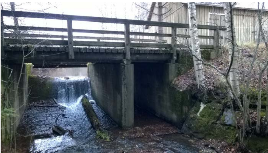
AKDG 5043:100. Sahajärven saha ja mylly. Nykyinen sahan siltarakenne, etelästä. Kuvaaja: Tuija Väisänen.
