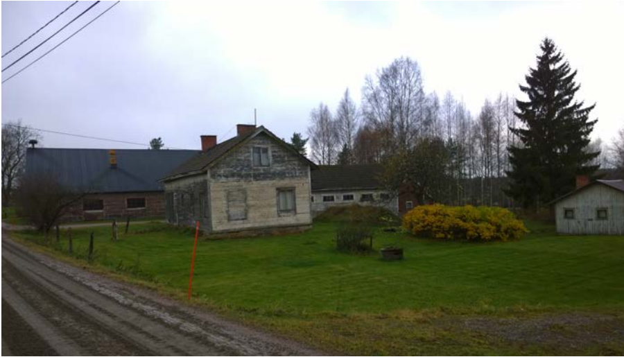
AKDG 5043:87. Levanto. Vanhempaa rakennuskantaa Levannontien pohjoispuolella, kaakosta. Kuvaaja: Petro Pesonen.
