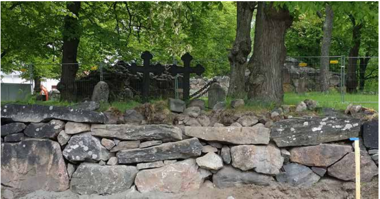
MuTu316012Dg_3. Läntinen kirkkoaita osittain korjattuna. 14.6.2016. Länestä, J.Lehtola
