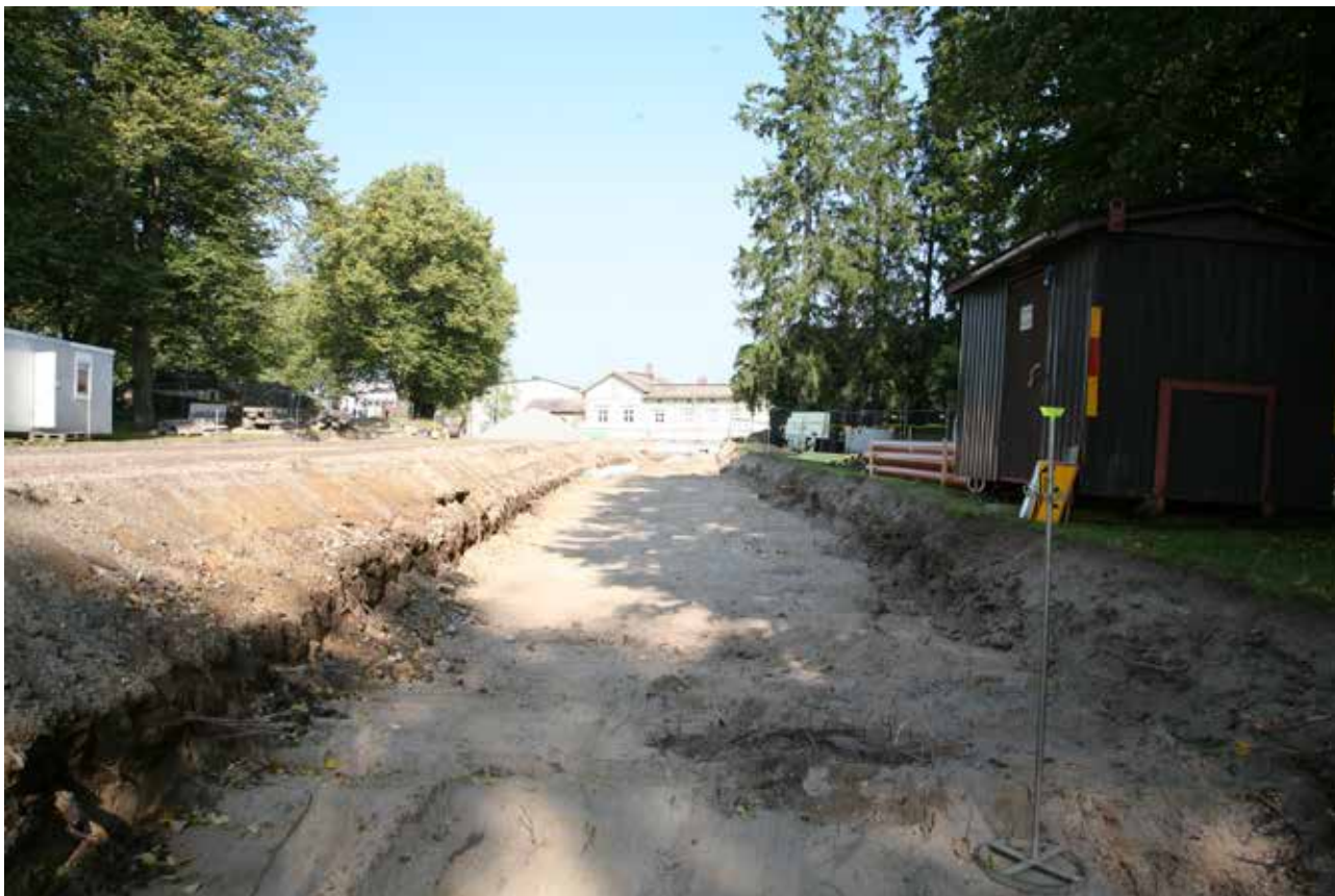
MuTu116012Dg_27. Itäkadun itäreunan puisto-osan valvottu kaivanto. 1.9.2016. Kaakosta. J. Haarala.
