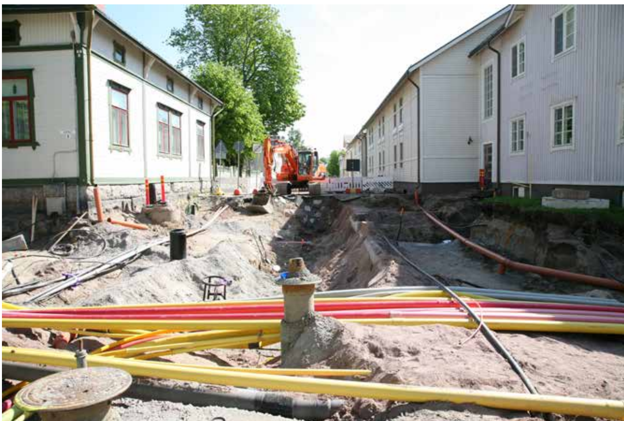
MuTu116012Dg_5. Alue 6. Valvotun kaivannon raja Kulmalankadulla. 30.5.2016. Pohjoisesta. J. Haarala.
