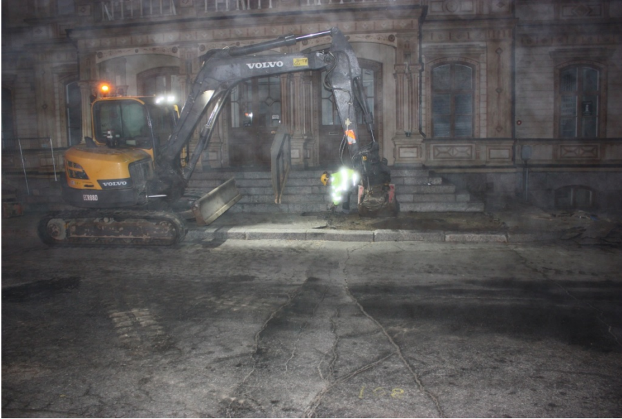
AKDG 4617:63. Koekuoppa portaiden lounaskulmassa. Asvalttia poistetaan. Kuvattu itään. Kuvaaja: Johanna Sepä.
