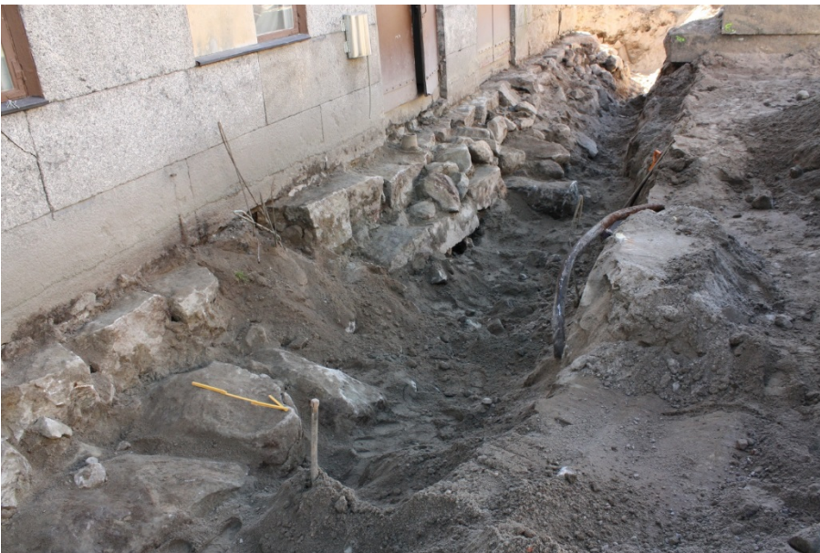
AKDG 4617:49. Pohjoisseinän itäosa, öljysäiliön kaivanto (L15). Kuvattu lounaaseen. Kuvaaja: Terhi Tanska.
