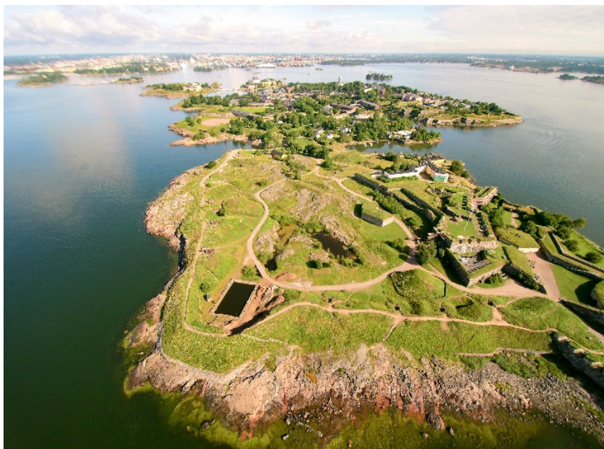
AKDG5066:2 ja AKDG5066:3 Yleiskuva kopterista. Patteri 3:n sortuma sijaitsee vesialtaan kaakkoispuolella kuvassa erottuvan varjon kohdalla. Etelästä. Kuva Vesa Laulumaa.
