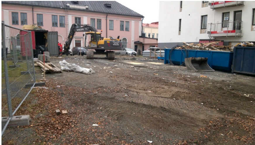
AKDG 4879: 34. Tontti pohjoiskulmasta kuvattuna ennen kaivutöiden aloittamista (Y0). Kuvaaja T. Taipaleenmäki.
