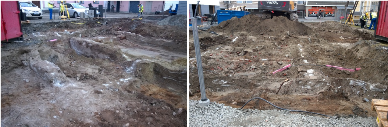
Rakenne R3, eli vuonna 1993 puretun Avelan talon "kivipuolen" jyrkät betoniperustukset. Vasemmalla AKDG 4879:38, oikealla AKDG 4879:83. Vasemmanpuoleinen kuvattu pohjoisesta, oikeanpuoleinen kaakosta, kuvaajat T. Tanska ja T. Taipaleenmäki.
