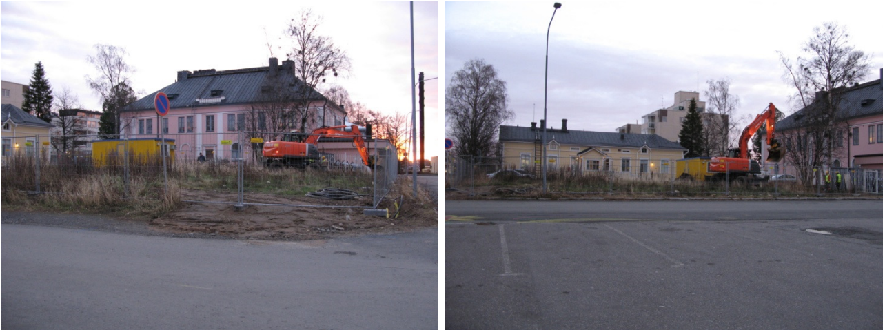
Yleiskuvia tontista ennen vuoden 2015 perustuskaivannon kaivun aloittamista. Vasemmanpuoleinen on otettu Eliaksenkadun ja Välikadun risteyksestä, oikeanpuoleinen Välikadun poikki, kadun toisella puolella olleelta parkkialueelta. Keltainen puurakennus on Avelan talo, ja vaaleanpunainen kivitalo on vanha Yhdyspankin talo, jossa nykyisin toimii Handelsbanken. Kuvat vuoden 2015 tutkimusraportista, AKDG 4495:1 ja 2. Kuvaaja T. Taipaleenmäki.
