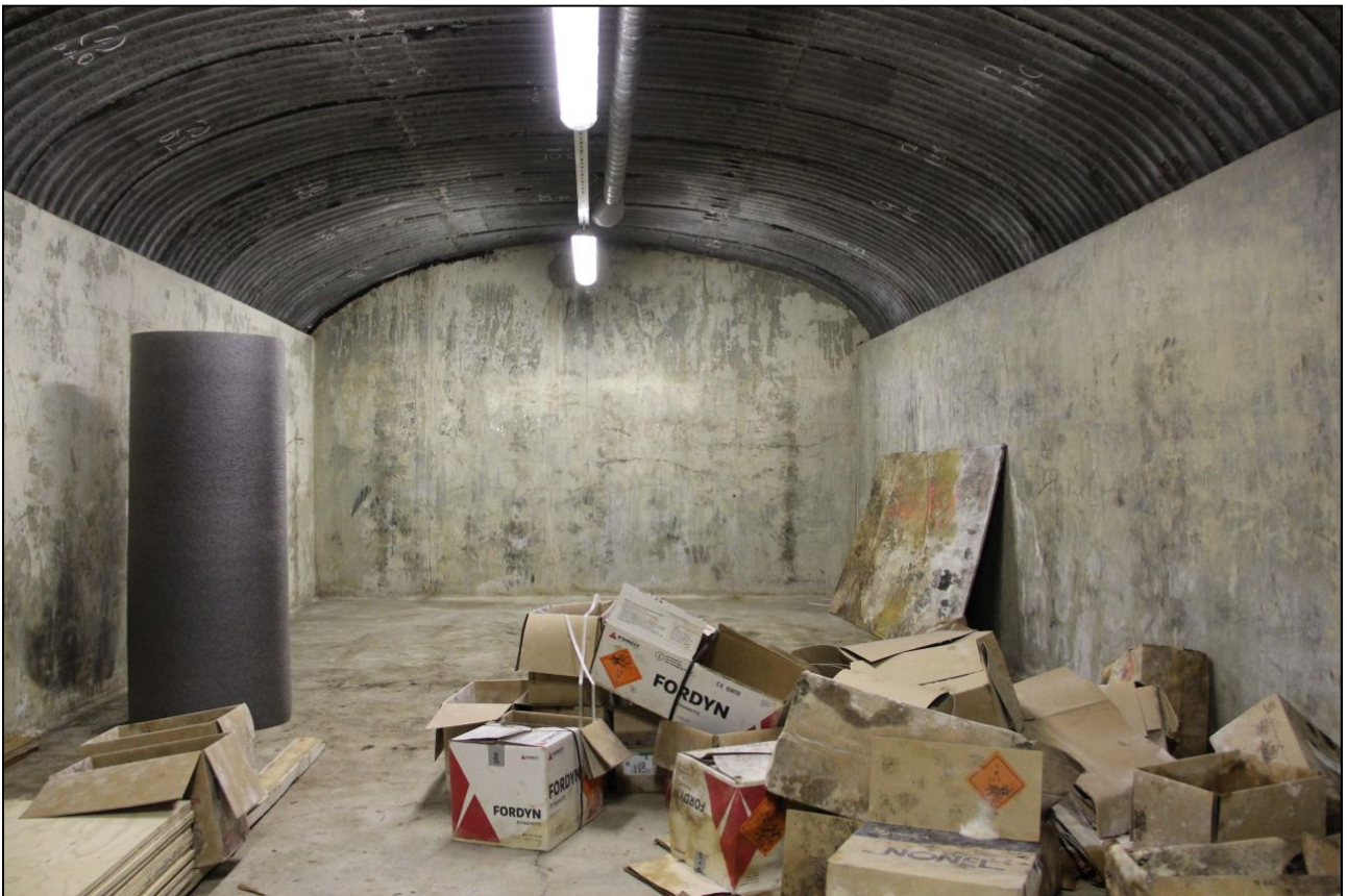
Kuva 17. Luolan G6 varastotilan takaseinä. Kuvattu pohjoisen suuntaan. Kuva: AKDG49189:23.
