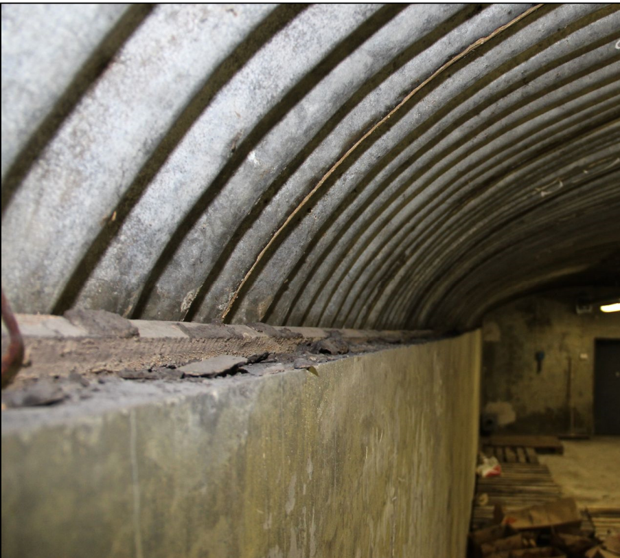
Kuva 19. Luolan G6 varastotila. Aaltopeltikatto on kiilattu alareunastaan lankulla betoniseinän ja kalliopinnan väliin. Kuvattu etelään suuntaan. Kuva: AKDG49189:22.
