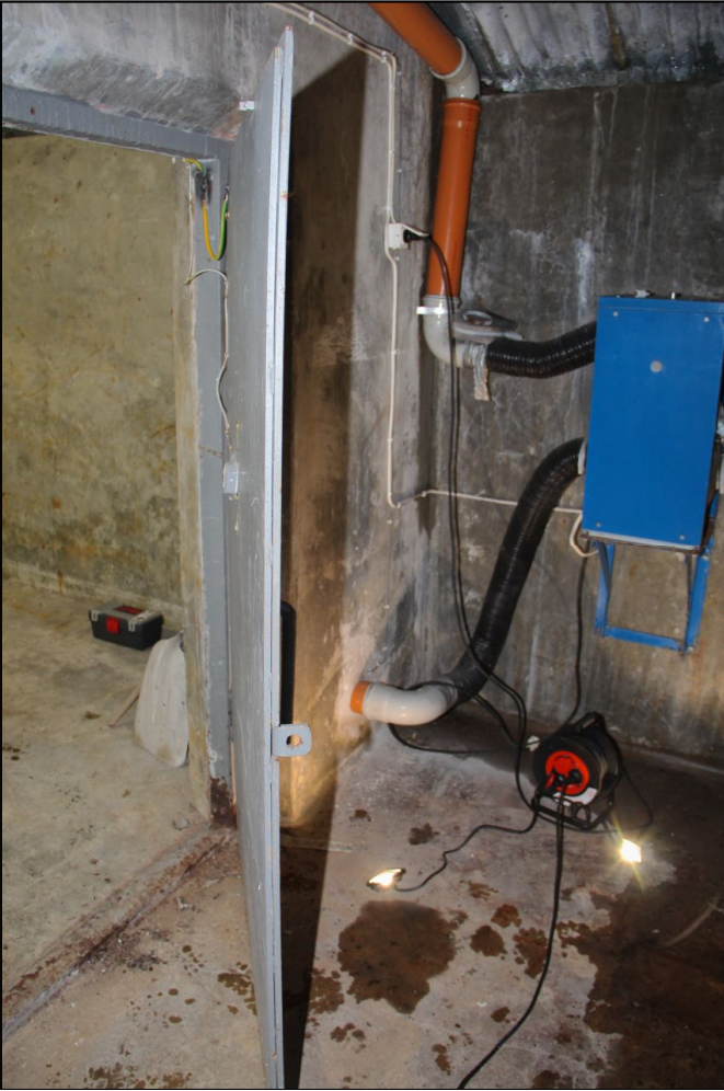
Kuva 23. Luolan G7 eteinen. Ovi varastotilaan ja myöhemmin asennettu kuivain. Kuvattu koilliseen. Kuva: AKDG49189:26.
