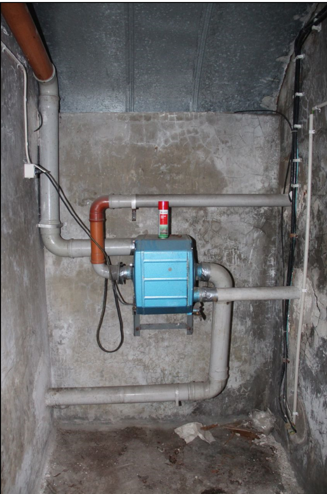
Kuva 13. Luolan G6 eteinen idän suuntaan kuvattuna. Alkuperäinen ilmanvaihtohormisto on purettu ja luolaan on myöhemmin asennettu uusi kuivain. Kuva AKDG49189:16.
