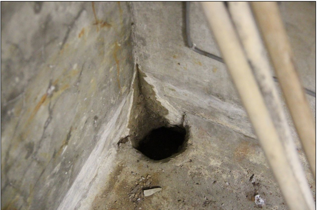
Kuva 30. Luolan G7 varastotilan lattian kaakkoisnurkan vedenpoistoaukko. Kuva: AKDG49189:41.
