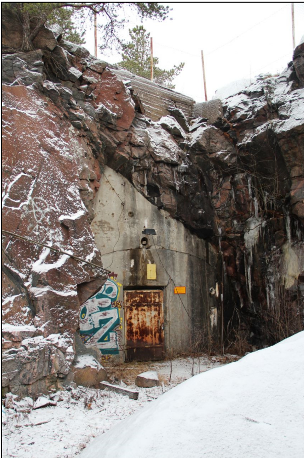
Kuva 10. Luolan G7 ulkoseinä. Etualalla oikealla lumen peittämä soräläjä. Kuva: AKDG49189:5.
