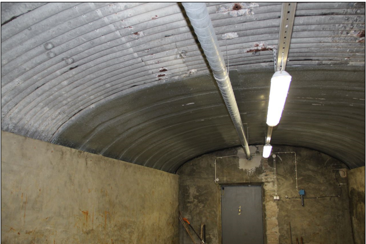
Kuva 28. Luolan G7 varastotila. Etualalla alkuperäistä peltikattoa, jota on taustalla uusittu viiden metrin matkalta. Kuva: AKDG49189:38.
