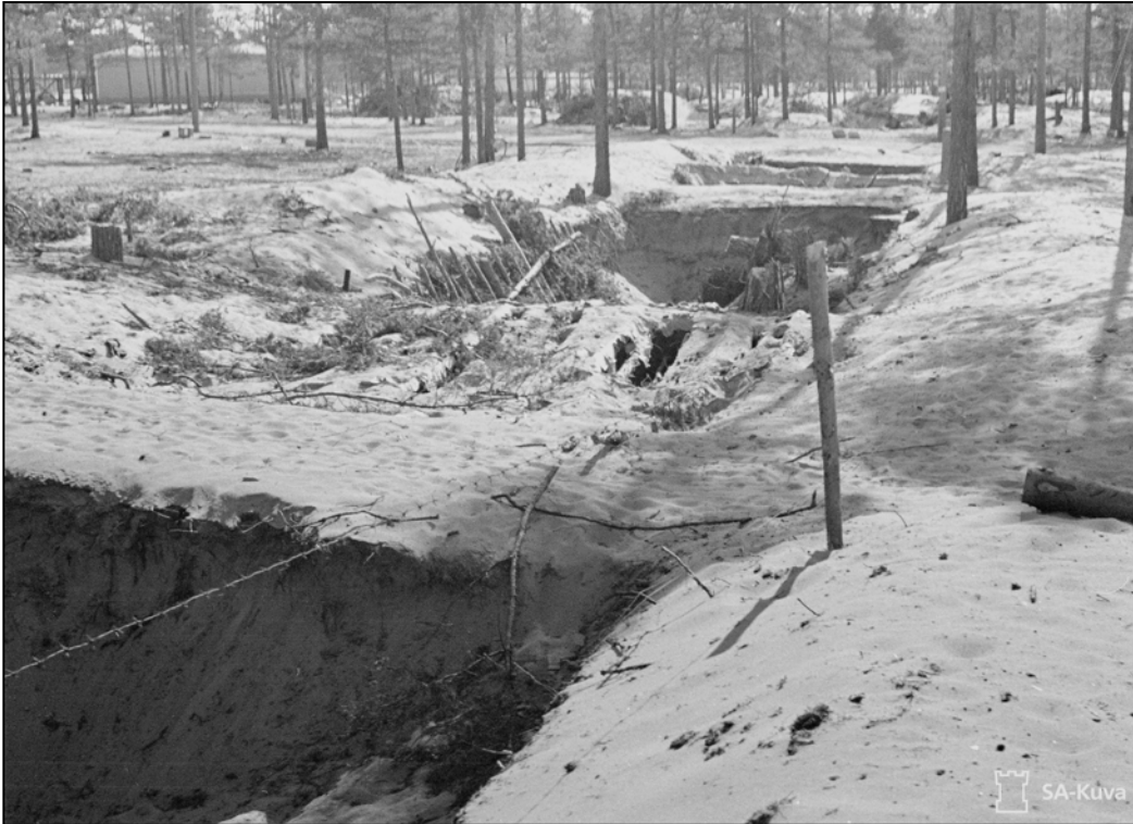
Kuva 19. Poikittaisvalleilla osioiksi jaetun kaivantoesteen päällä oleva riukunaamiointi on osittain sortunut. SA-kuva 86514. Alarik Öhrnberg.
