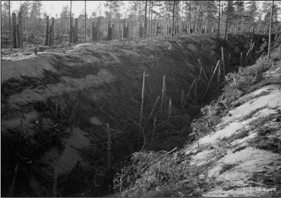
Kuva 18. Kaivantoeste. Suoraviivaisesti kaivetun esteen pohjalla on teroitettuja puupaaluja. Esteen takana on rivissä kiskoesteen paaluja. SA-kuva 114599. Alarik Öhrnberg, 1942.
