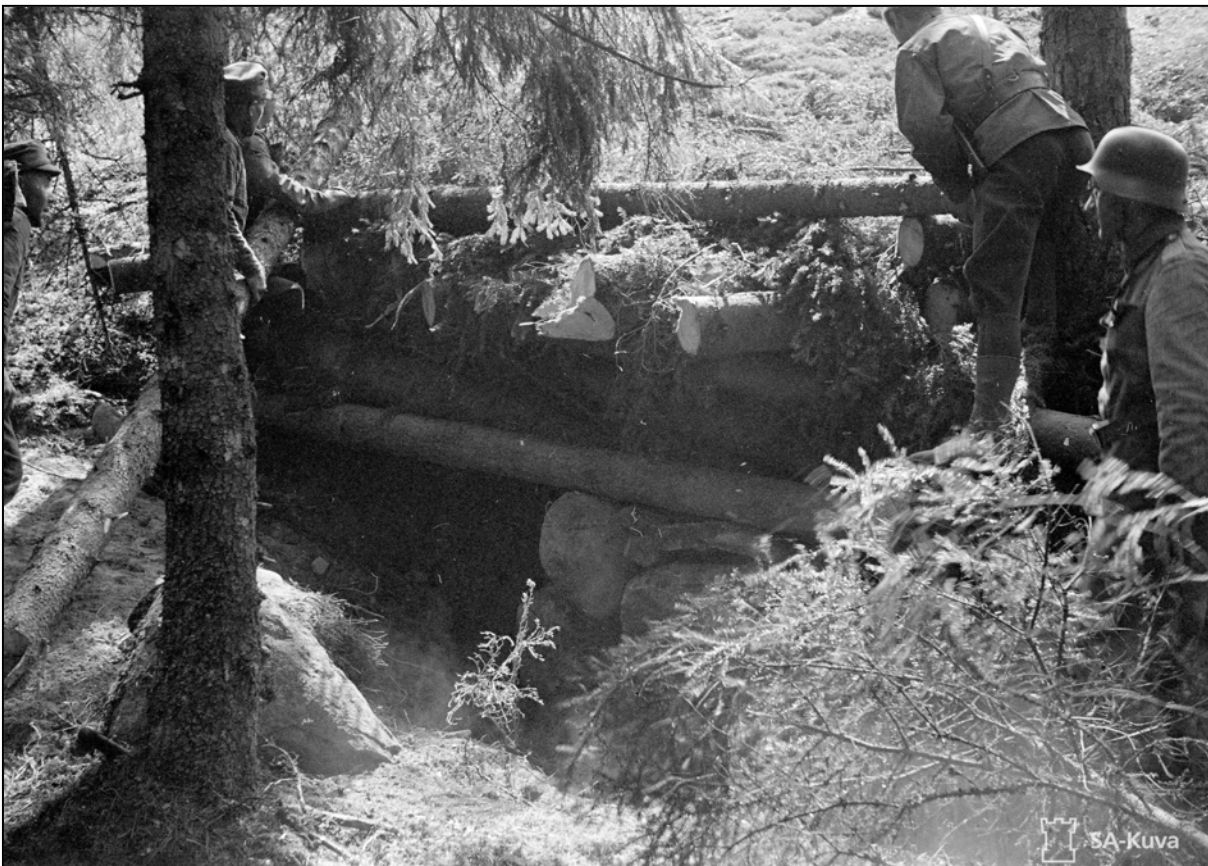
Kuva 22. Suomalaiset sotilaat rakentavat korsua Hangon rintamalla. SA-kuva 24184. Aukusti Tuhka.
