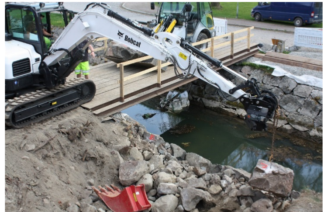
AKDG4721:20 Toisen kivikerroksen kiviä nostetaan kaivinkoneella pois eskarppimuurista. Kuva Katja Vuoristo.
