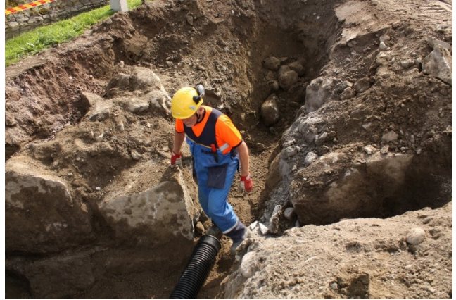
AKDG4721:82 Raveliin oikean sivun eskarppimuurin kohdalle asennetaan sadevesiputkea. Kuva Katja Vuoristo.
