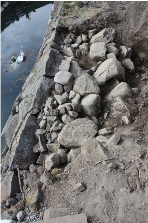
AKDG4721:19 Eskarppimuurin 2. kivikerros, rakenne R3. NE-SW. Kuva Katja Vuoristo.
