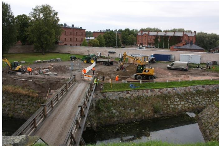
AKDG4721:83 Yleiskuva putkikaivannon haarauman kohdasta sillan oikealla puolella. SE-NW. Kuva Katja Vuoristo.
