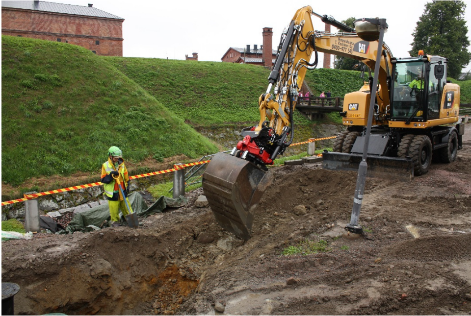
AKDG4721:71 Johanna Seppä valvoo, kun raveliin oikean sivun kontreskarpimuurin kiviä alkaa tulla esiin. Taustalla pressujen alla vuonna 2015 esiin kaivettu kiveys. NW-SE. Kuva Katja Vuoristo.
