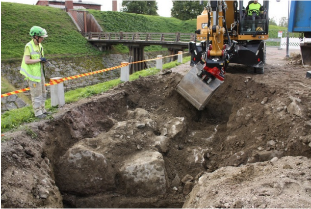
AKDG4721:79 Raveliin oikean sivun eskarppimuurin ensimmäistä kivikerrosta on purettu asennettavan sadevesiputken kohdalta. N-S. Kuva Katja Vuoristo.
