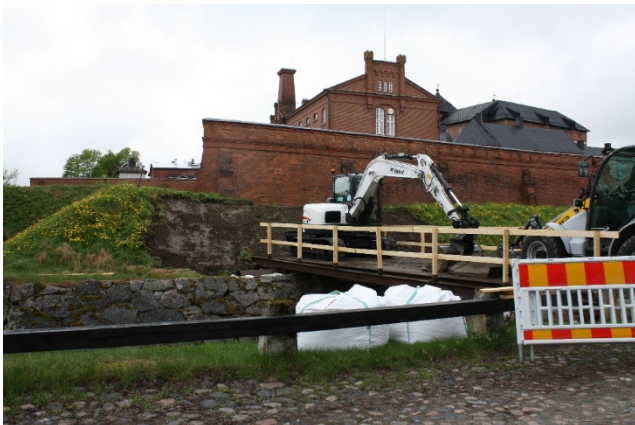
AKDG4721:1 3. puolibastionin kunnakerrosta poistetaan. SW-NE. Kuva Katja Vuoristo.
