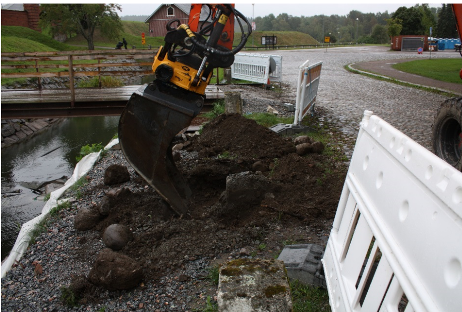
AKDG4721:61 Aitatalpan 1 paikkaa kaivetaan. SW-NE. Kuva Katja Vuoristo.
