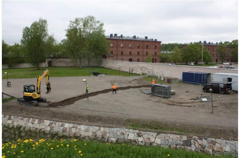
AKDG4721:54 IKJ Rakennus Oy:n työmaan sähkökaapelia kaivetaan linnan pohjoispuoliselle hiekkakentälle. E-W. Kuva Katja Vuoristo.
