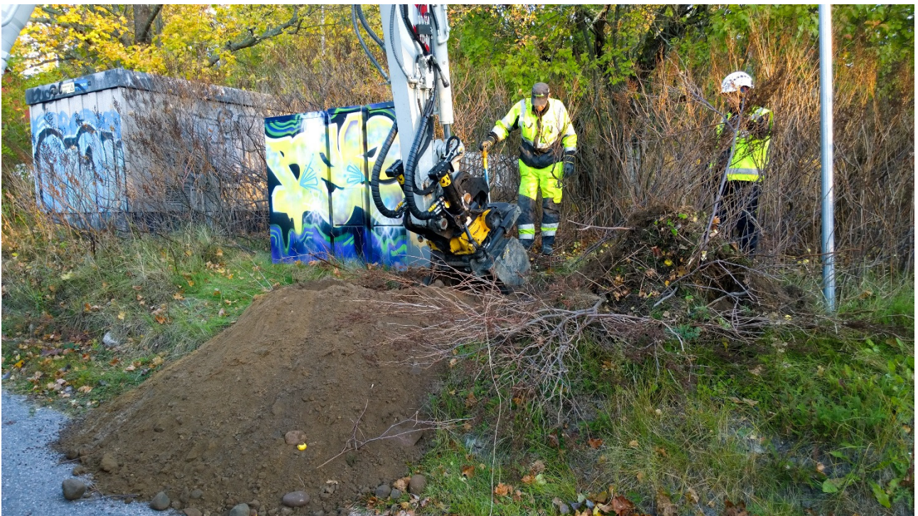
Kuva 1. Uusi jakokaappi asennettiin välittömästi vanhan kaapin viereen. Kuvattu luoteeseen. Kuva: Satu Koivisto/ARKE (AKDG 5202:7).
