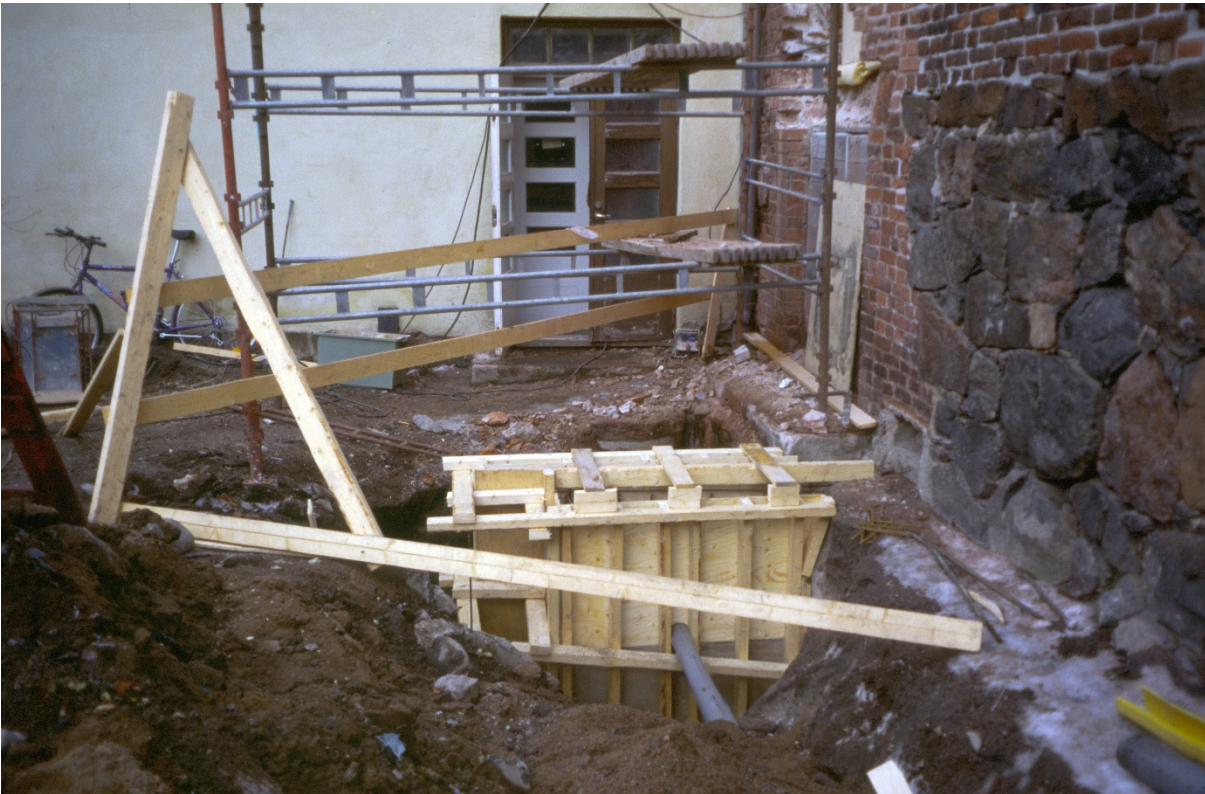
Kuva 2. Henkilönostimen perustustyöt käynnissä juhlasalin eteläseinustalla vuonna 1998. Kuva: Suomenlinnan hoitokunta.
