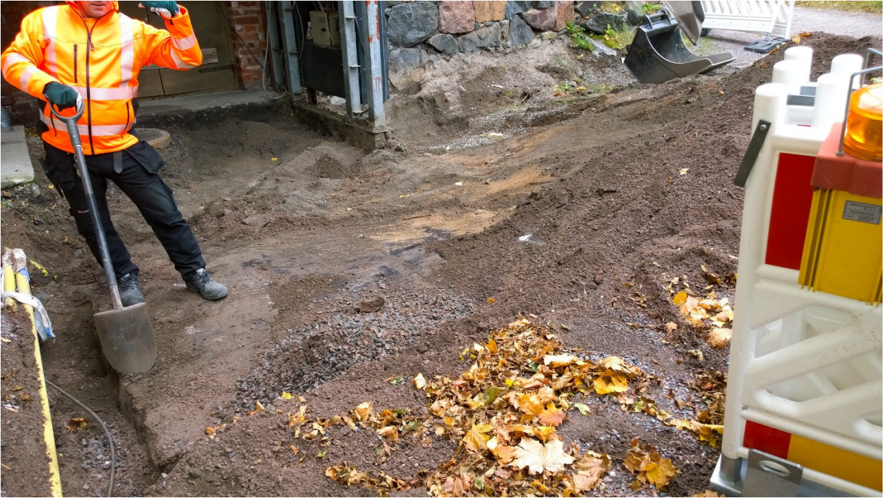
Kuva 5. Vanhan latriinikaivon betonikansi paljastuu sisäänkäynnin länsipuolelta. Kuvattu kaakkoon. Kuva: Satu Koivisto/ARKE (AKDG 5204:6).
