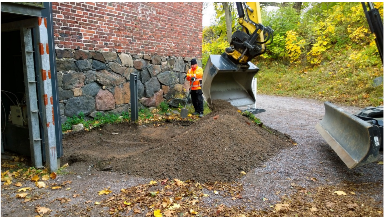
Kuva 4. Uutta asennuspaikkaa kaivetaan rakennuksen seinän myötäisesti lounaaseen. Kuva: Satu Koivisto/ARKE (AKDG 5204:3).
