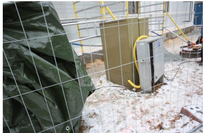
Oikealla AKDG5205:16 Tietoliikennekaapeliinjan päätepiste eli kaivannon 6 tuleva kohta. Kuvattu koillisesta. Kuvat Esa Mikkola.
