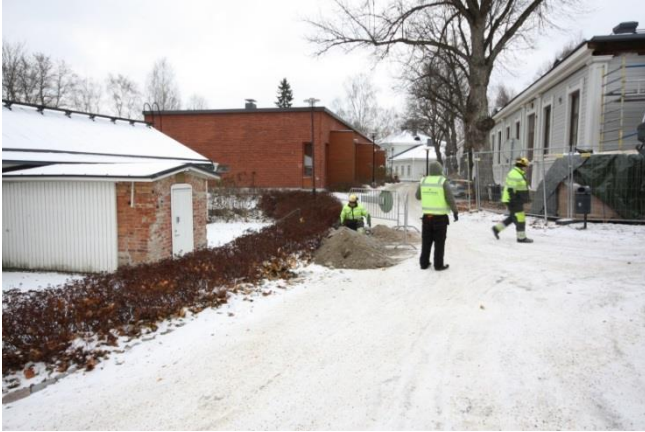
AKDG5205:14 Kaivannon nro 5 kohta. Kuvattu pohjoisesta.
