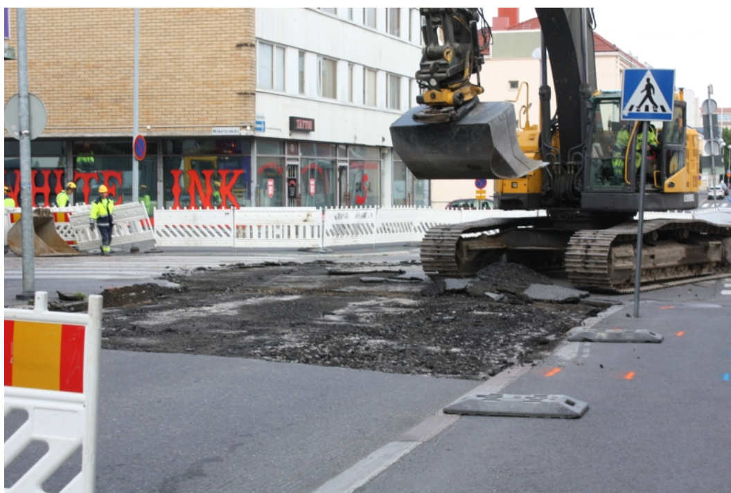
AKDG5200:1. Yleiskuva katutöiden aloittamisesta ja alueen avaamisesta kaivinkoneella. Kuvattu kaakosta 9.8.2016. Kuva Tiina Kuvaja/Arkeologiset kenttäpalvelut
