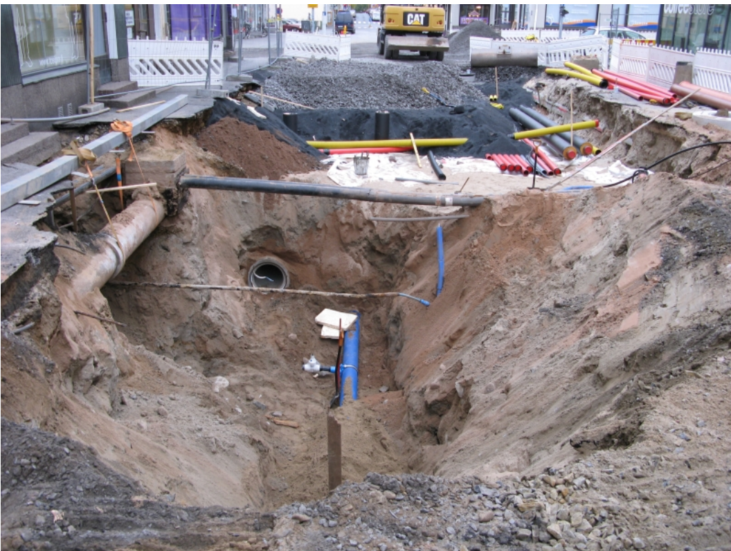
AKDG5200:13. Auki kaivettu alue Asemakadulla. Kuvattu kaakosta kohti Mäkelininkadun risteystä 11.10.2016. Kuva Pauli Haapakangas/Arkeologiset kenttäpalvelut
