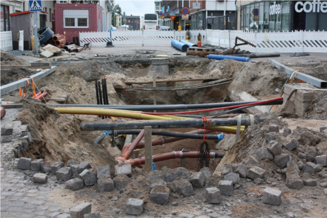
AKDG5200:3. Yleiskuva valvonta-alueesta, joka oli täynnä vanhoja kaivantoja, putkia ja kaapeleita. Kuvattu lounaasta 18.8.2016. Kuva Tiina Kuvaja/Arkeologiset kenttäpalvelut
