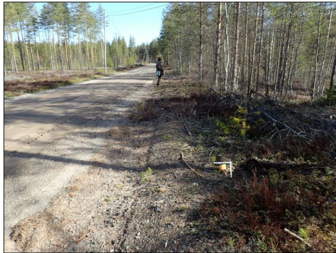
Haaruskangas A:n eteläistä osaa, Haaruskankaantien itälaitaa pohjoiseen. Vesijohto rakennetaan kuvan suuntaisesti tien laitaan. Pohjoiskoilliseen.
