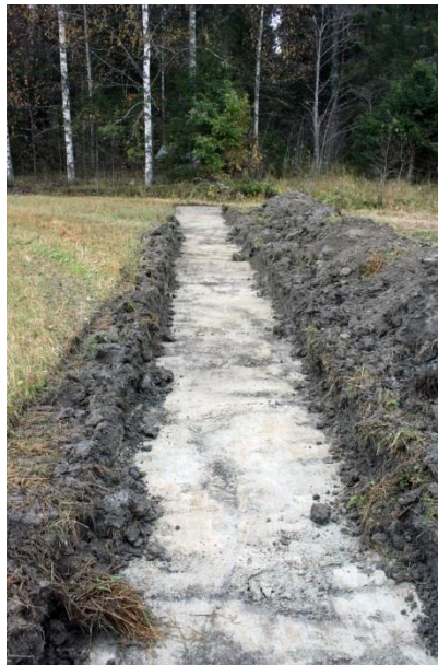
Kuva 14. Koeoja nro 7, kuvattu poh- joisesta. AKDG 5175:12
