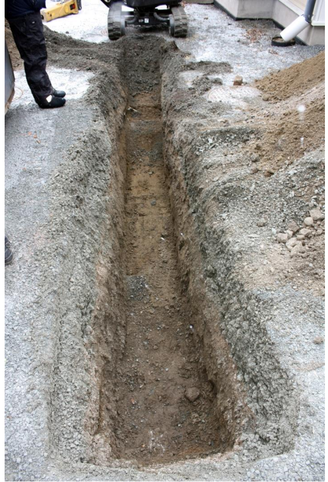
Kuva 7. Valvottu putkioja, kuvattu pohjoisesta. AKDG 5201:6
