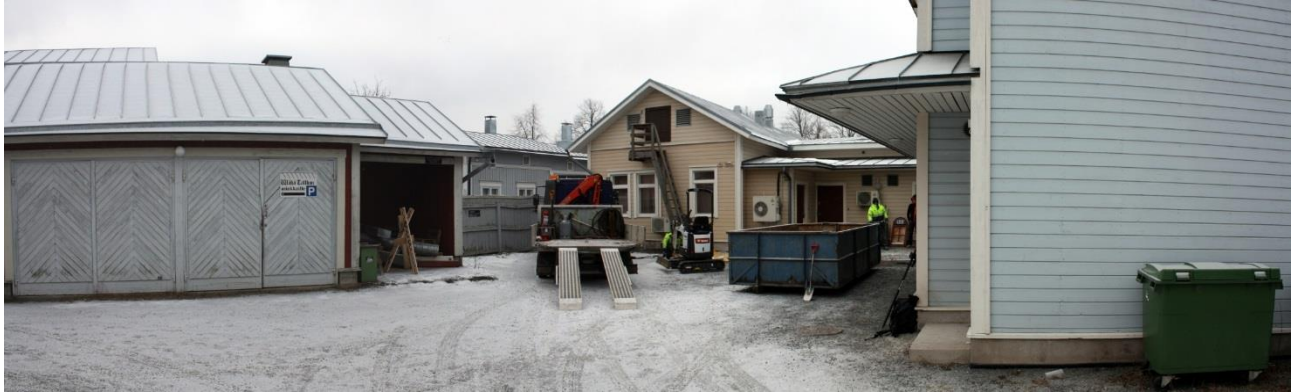
Kuva 2. Tutkimuskohteena oleva Wähä-Saukon talon piha, kuvattu koillisesta. AKDG 5201:2
