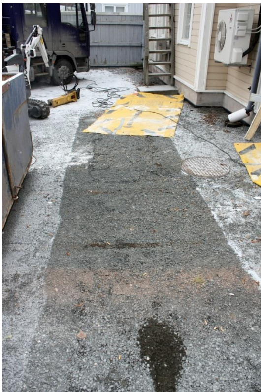
Kuva 5. Tulevan viemäriputken sijainti ennen kaivaustyön aloittamista, kuvattu pohjoisesta. AKDG 5201.3
