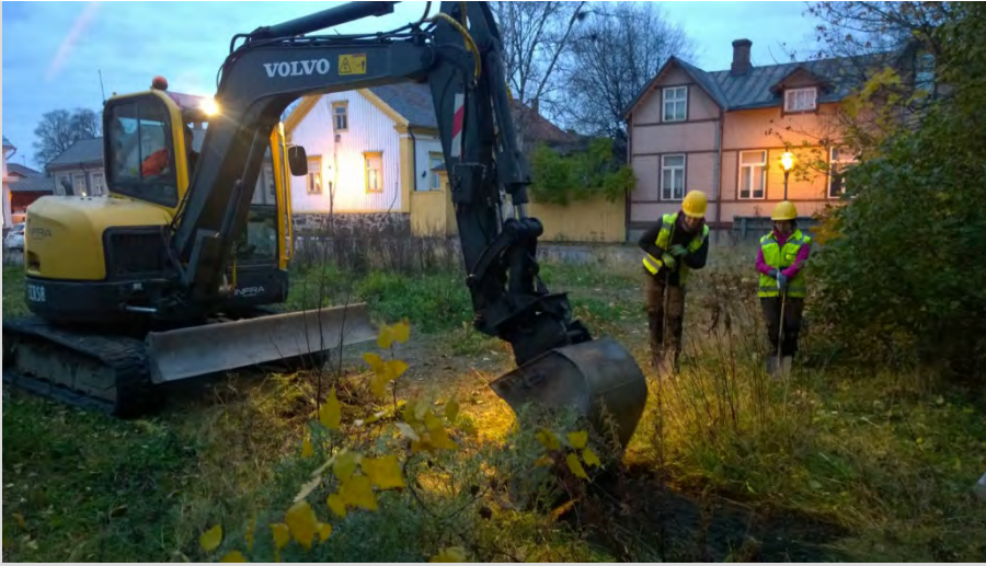
AKDG 5187:5. Työtä aloitellaan, etelästä. Kuvaaja: Petro Pesonen.
