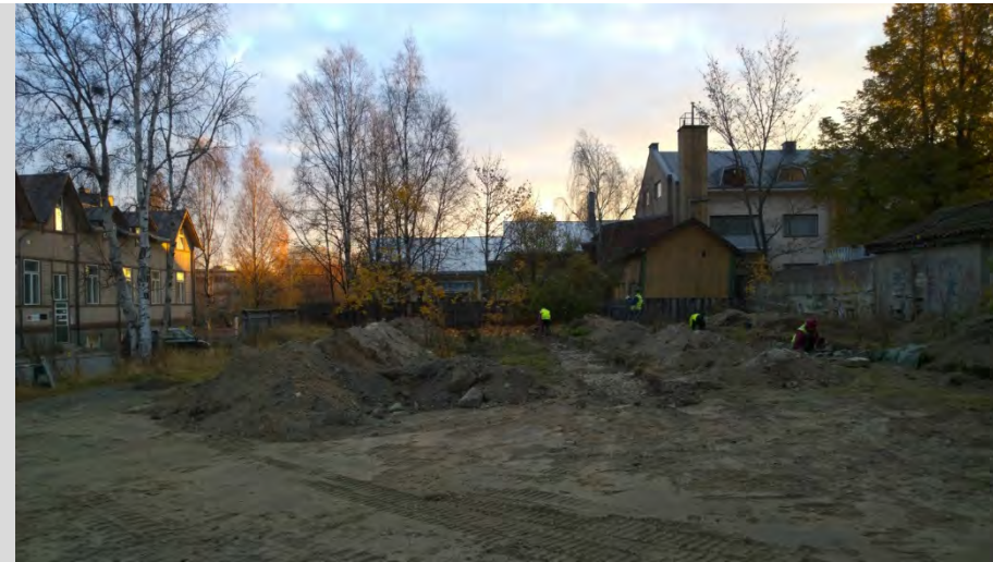
AKDG 5187:109. Kaivaus käynnissä aamulla 26.10, lännestä. Kuvaaja: Petro Pesonen.
