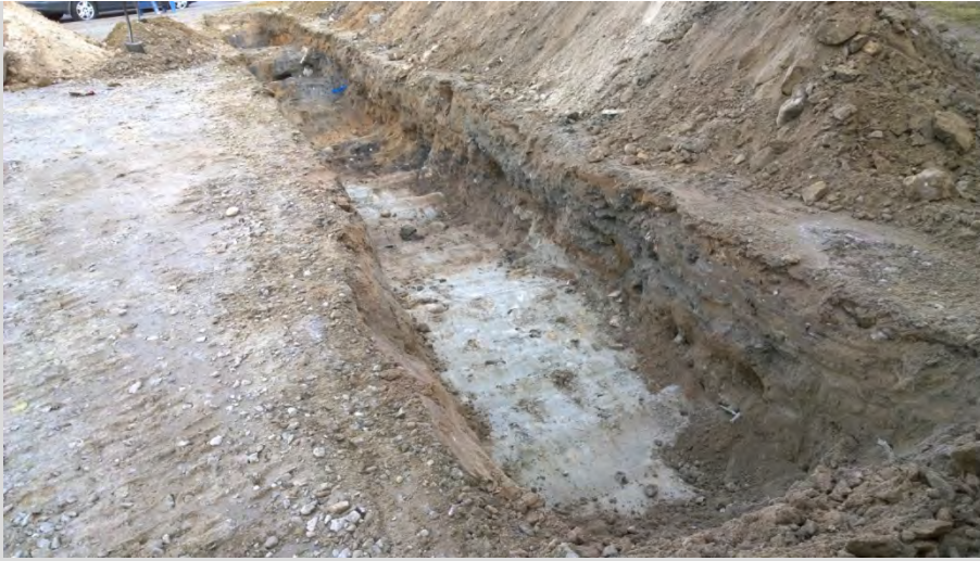
AKDG 5187:91. Koeoja 4 kaivettuna, lounaasta. Ku- vaaja: Petro Pesonen.
