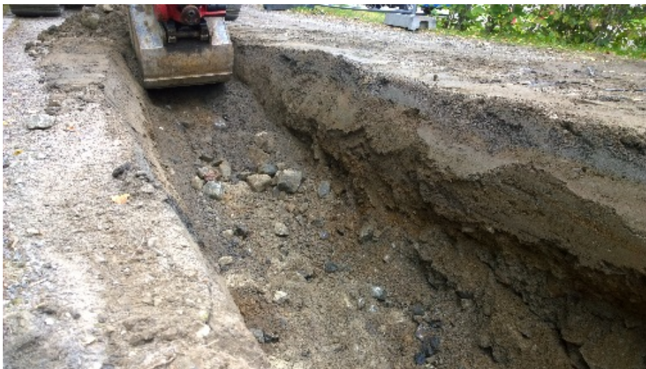
AKDG5203:9 Kaukolämpökaivantoa kaivetaan. Ojan profiilissa erottuu pihatien alaisia tien täyttökerroksia. N-S. Kuva Petro Pesonen.
