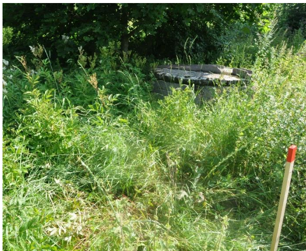
Alueen 4 eteläisimmän rakennuspaikan kohdalla oleva moderni viemärikaivo. Lännestä.
