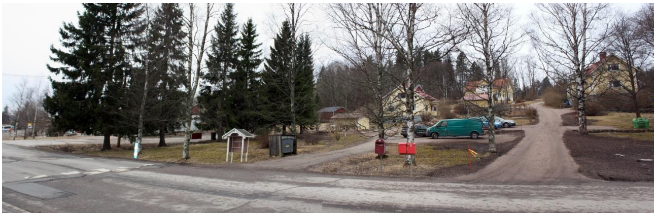
Kuva 1. Tutkimuskohteena oleva kiinteistö, kuvattu idästä. AKDG 5210:1
