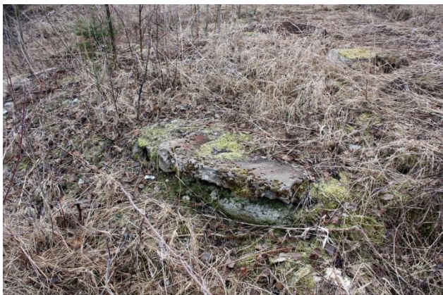
Kuva 14. Betonilattia rakennusjäännöksessä R2, kuvattu lännestä. AKDG 5268:13
